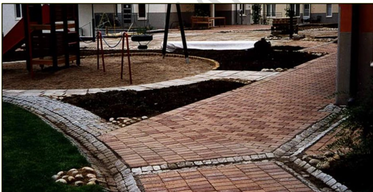
Figur 6-2. Exempel på avledning av takvatten via rännalar anlagda med gatsten (Källa: Stockholm Vatten AB, n.d.).
