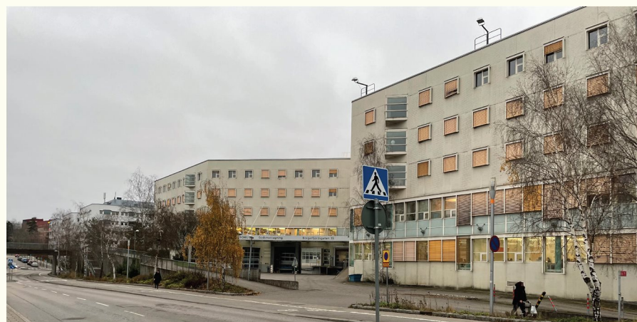
Borgarfjordsgatan med IBM Forum närmast i bild, längre bort utmed vägen syns Kv Hornafjord 1, 2 och 3
