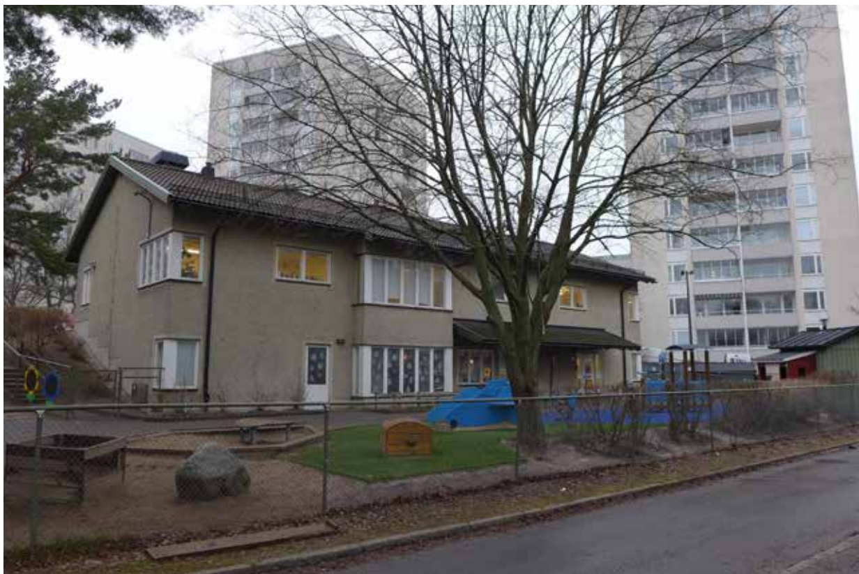
Förskolebyggnaden från sydöst, foto AIX 2017-12-20.
