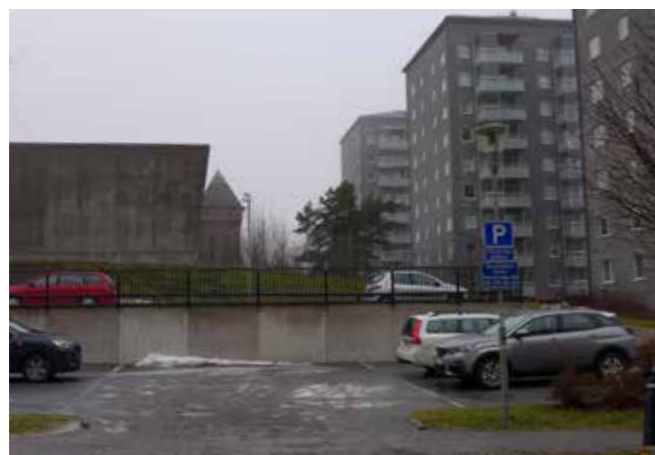
Reservoaren med sitt torn till vänster. Till höger de tre höghusen från 2010-talet.
