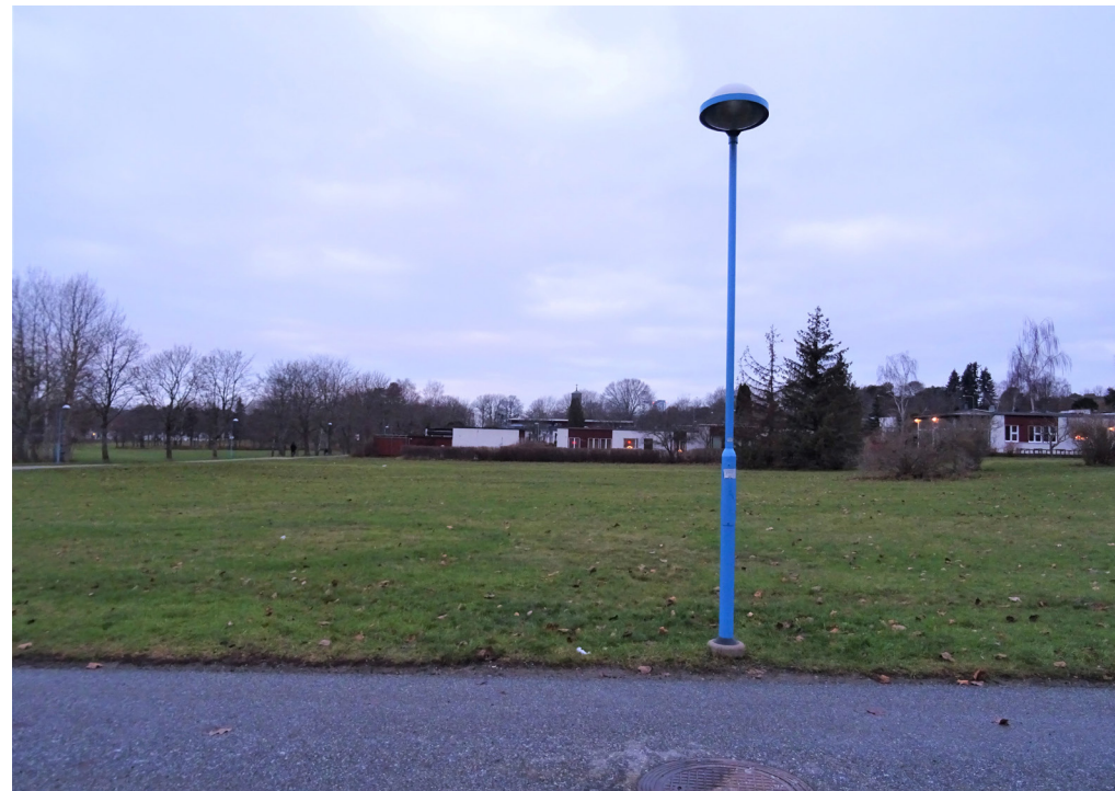
Belysningsarmatur karaktäristisk för gångvägarna i Spångadalen.
