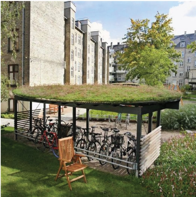
Exempel på väderskyddad cykelparkering med grönt tak
