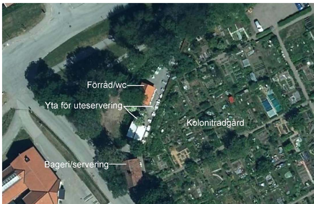
Bageri och servering i den gamla trädgårdsstugan. Förrådsbyggnaden tillkom 2015. Flygfoto Eniro.
