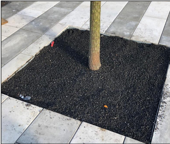
Figur 19 Biokol i en trädplantering vid Sergels torg, Stockholm. Kolet skall täckas med gjutjärnsgaller. Foto: Norconsult AB.
