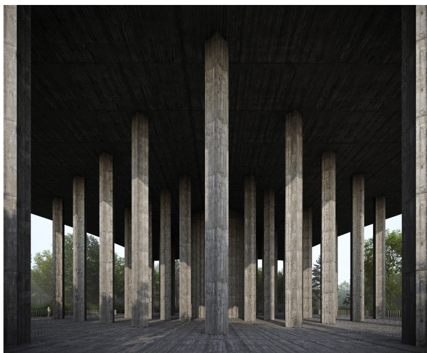
Vattencisternen vilar på ett mittorn omgärdat av en pelarsal med 60 stycken pelare med en minsta frihöjd om 14,5 meter.
