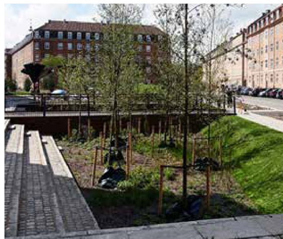
Figur 68: Exempel på ett torg med tydliga inslag av dagvattenhantering i nedsänkta grönytor, Tåsinge Plads i Köpenhamn.
