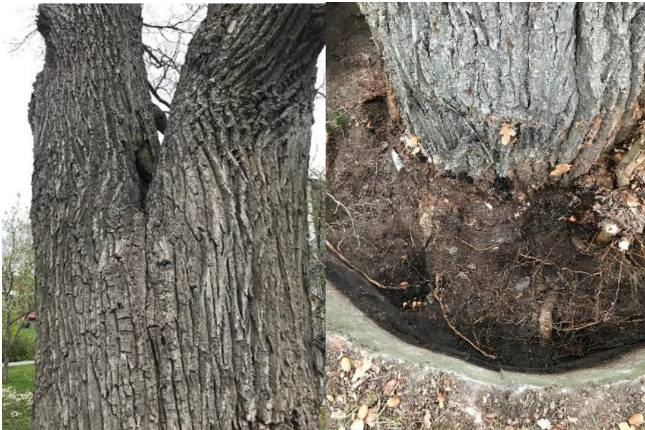
Fig 8. Till vänster stor genomgående stamspricka med omfattande röta. Till höger marken kring stammen är uppfyllt från ursprunglig marknivå uppemot 90 cm, hos träd nr 7.
