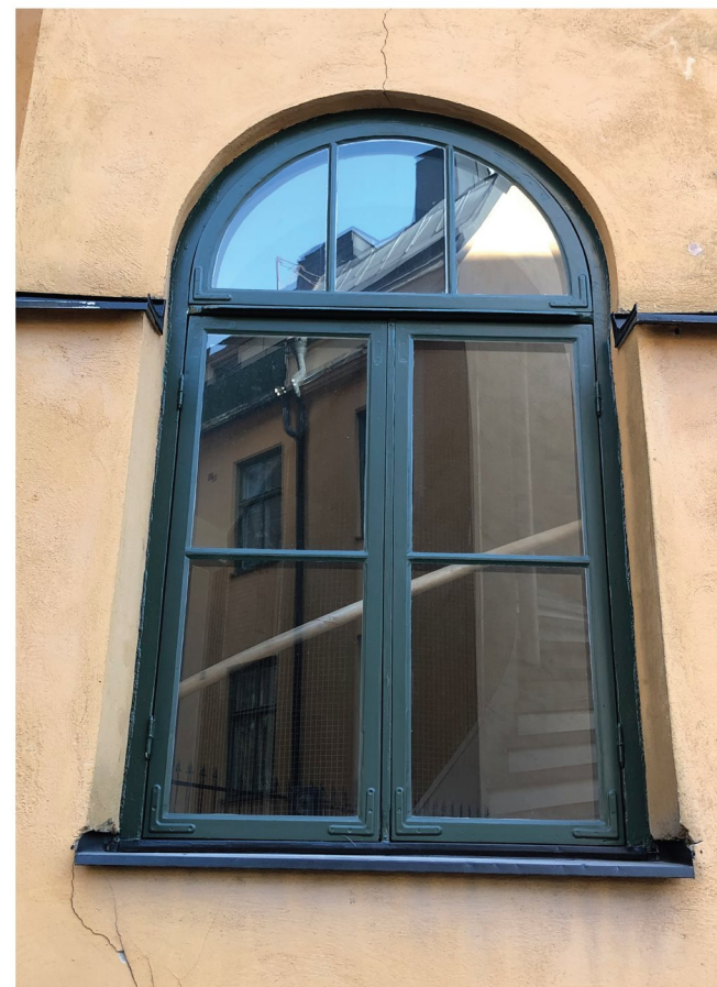
Detalj av äldre fönster i trapphuset mot gården.
