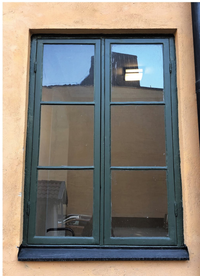
Detalj av ett troligtvis bevarat ursprungligt fönster i gathuset. Placerat i anslutning till huvudentrén och trapphuset, till höger om körporten i gårdsfasaden.
