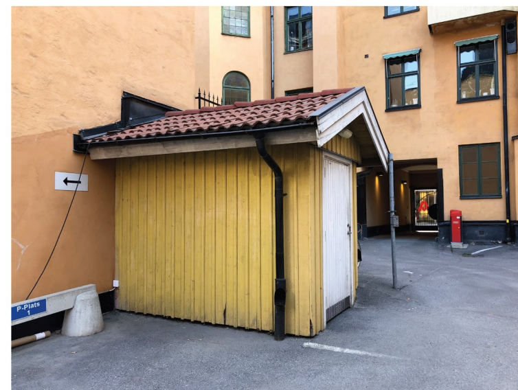
Sophus på innergården uppfört under tidigt 1990-tal.
