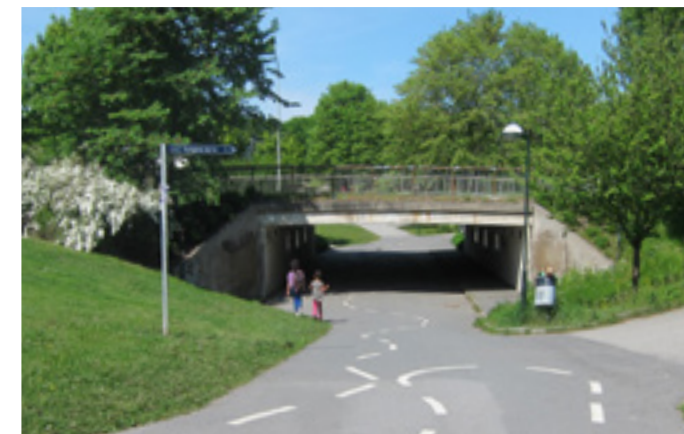
Figur 6. Gångtunnel under Vårbergsvägen.
