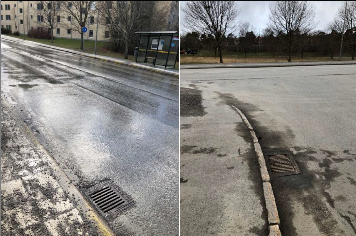
Figur 13. Avledning av dagvatten i dagvattenbrunnar. Bilden till vänster visar en dagvattenbrunn i Folkparksvägen medan bilden till höger är en brunn i Safirgränd i den östra delen av utredningsområdet (Foto: Norconsult)
