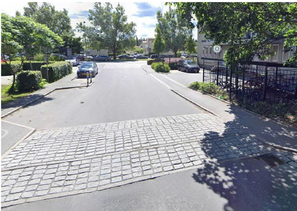
Figur 10. Lågpunkt i infartsgata från Handelsvägen, foto taget mot söder och Handelsvägen. Lågpunkten förstärkt av Fartdämpande åtgärder med gatsten åt både norr och söder. Åtgärder planeras för att åtgärda lågpunkten.
