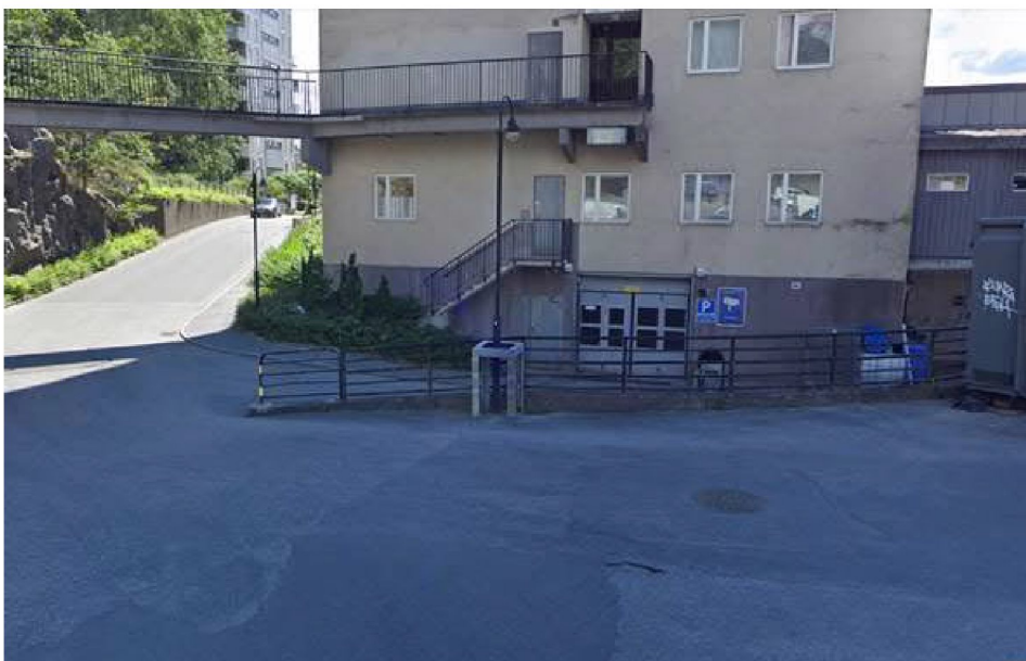
Figur 9. Lågpunkt vid garagenedfart, foto taget från befintlig parkering mot söder. Garageinfart bakom räcke med garageport längst till höger i bild.
