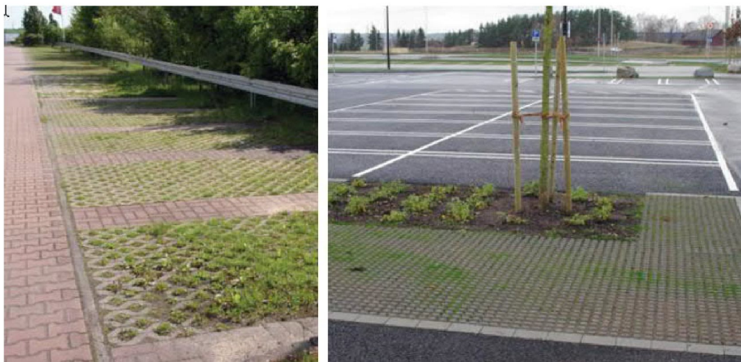
Figur 12. Exempel på rasterytor (betonghålststen samt permeabel asfalt) 21 .
