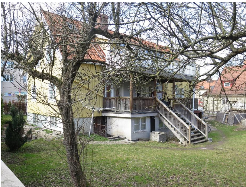
Kavelbron 19, bostadshuset sett från trädgårdssidan. Jämfört med ursprunget är huset avsevärt ombyggt. Det är förlängt mot norr och taklättan, de två altanerna samt källaren under dessa har tillkommit i senare tid. Foto: Förf. våren 2021
