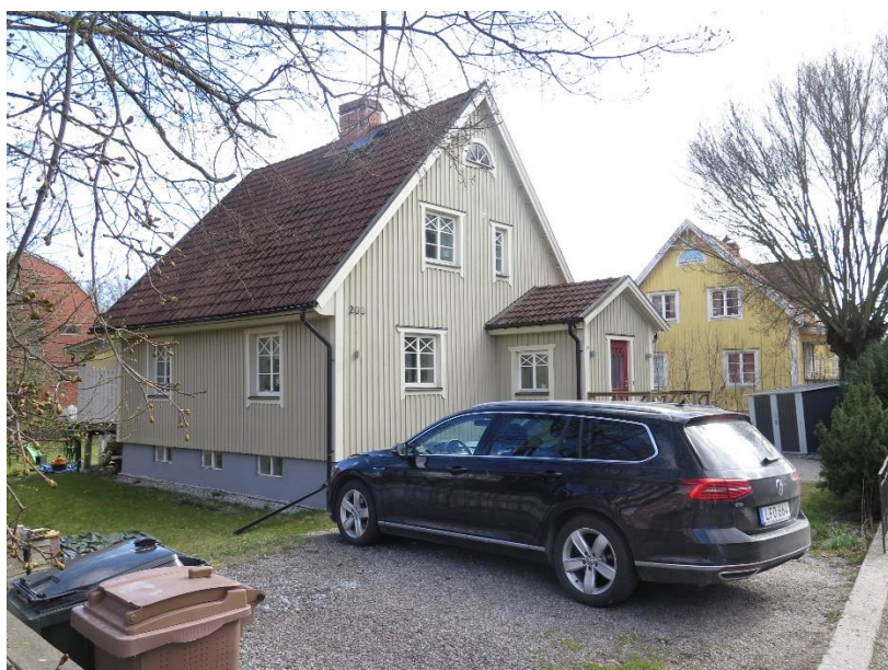
Villan på fastigheten Kavelbron 11 som den ser ut idag avbildad från nordost. Sjättenovembervägen går alldeles bakom fotografen. Bortsett från en täckt och en öppen altan samt den grusade parkeringsplatsen finns den äppelträdsbevuxna trädgården bevarad runt huset. Till höger ans den gula villan på Kavelbron 19.
