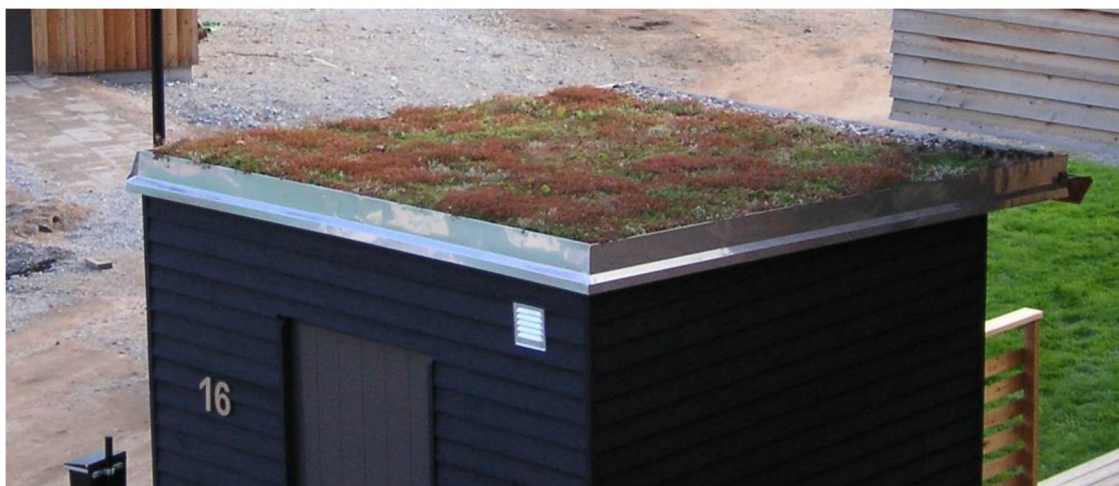
Figur 10. Exempelbild på grönt tak i Sollentuna. Foto: WRS (2005-08-07).
