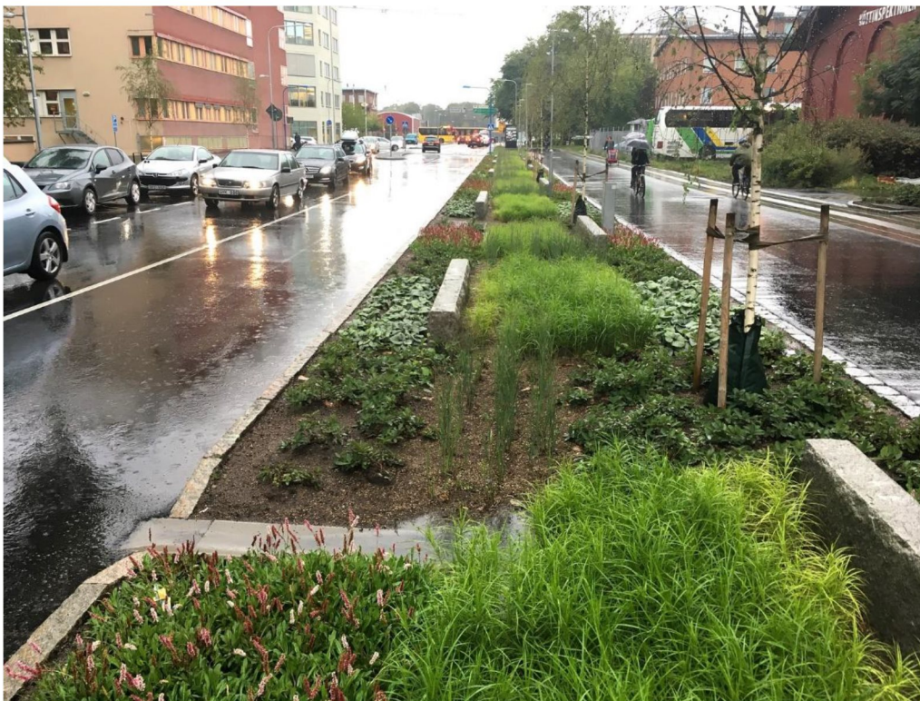
Figur 11. Exempelbild på nedsänkt växtbädd i Uppsala. Foto: WRS (2019-09-20).
