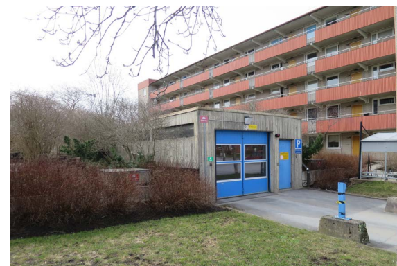
Figur 6 Nedfart till parkeringsgarage, i bilden syns också befintligt loftgångshus.
