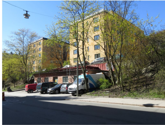
Nedre Lundagatan, pumphuset (tryckstegringsstationen) i tegel.
