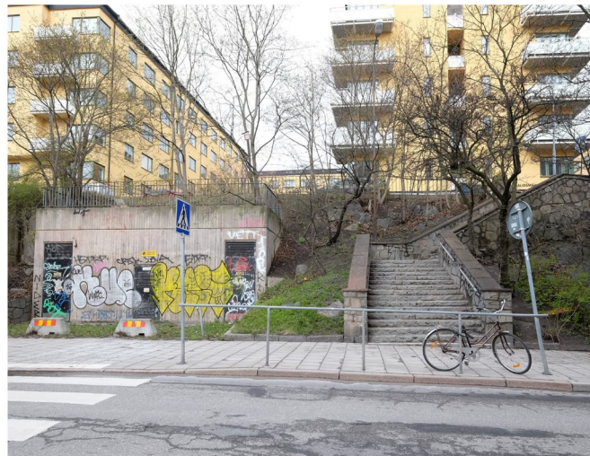
Elcentral i platsguten betong vid trappan.
