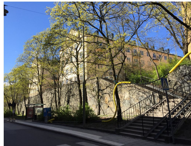
Nedre Lundagatan, stödmur i granit med rad av planterad lönn mot gata. Västra trappan i granit med smidesräcke.
