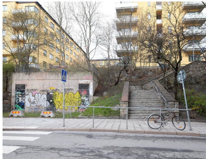
Elcentral i platsguten betong vid trappan.
