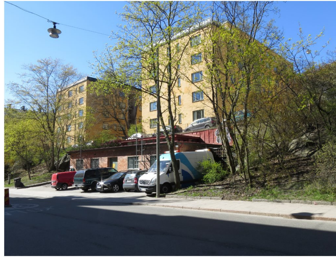
Nedre Lundagatan, pumphuset (tryckstegringsstationen) i tegel.
