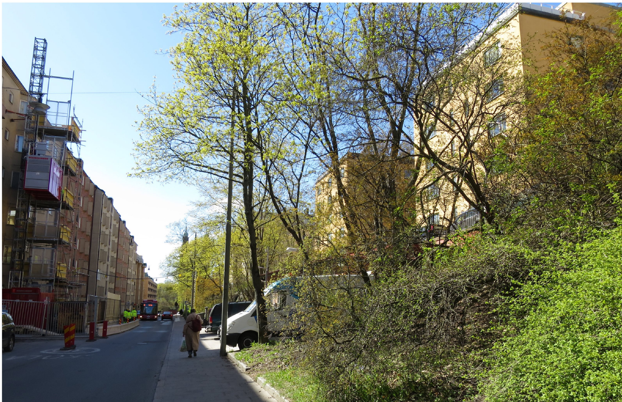
Nedre Lundagatan där slänten är som djupast. Vy mot väster.
