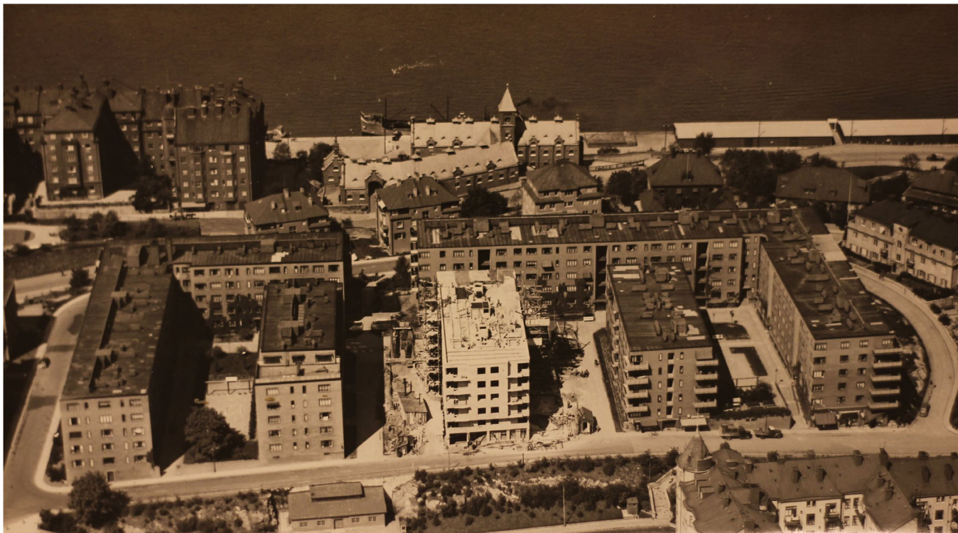
T.v: Flygfoto från söder över kvarteret Marmorn 1939. Längst fram i bilden syns bergsskärningen med den stort anlagda trappan. Bredvid trappan syns en liten kur av okänt slag jämte nyanlagd buskplantering i slänten. Längre till vänster det nyligen uppförda pumphuset (tryckstegringsstationen). Uppe på berget håller den mittersta lamellen på att färdigställas. Foto: Oscar Bladh. Källa: HSB-arkiv
