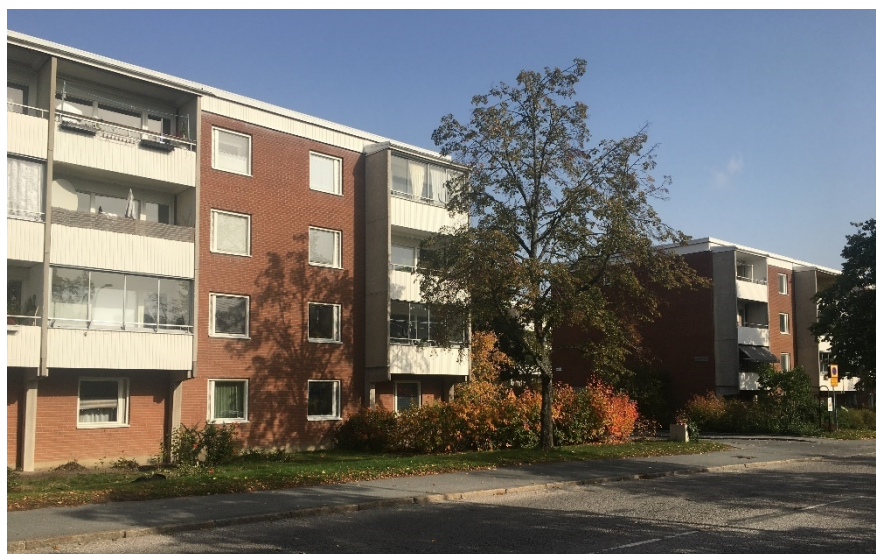
Bebyggelsen norr om Byälsvägen utgörs av bostadshus i tre våningar utförda i rött tegel med platta tak.
