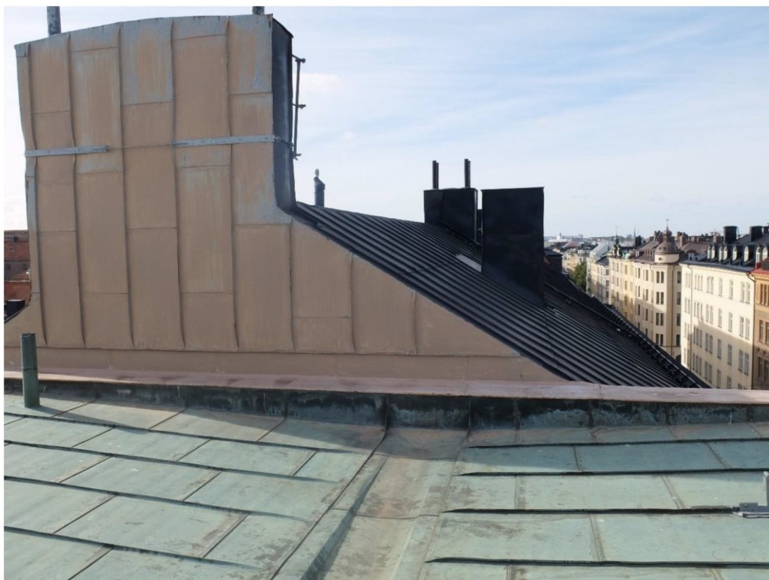
Det plåtklädda taket i koppar på Storken 13 möter här gaveln på Storken 12 som även är plåtklädd. Sannolik mötte det äldre rivna huset gaveln mot grannfastigheten på ett annat sätt.
