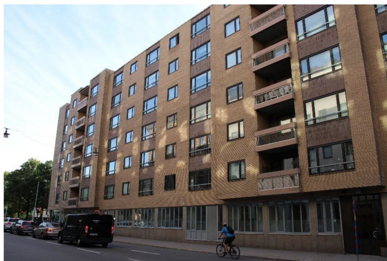
Fasad mot Sibyllegatan, Notera de utbytta fönstren.
