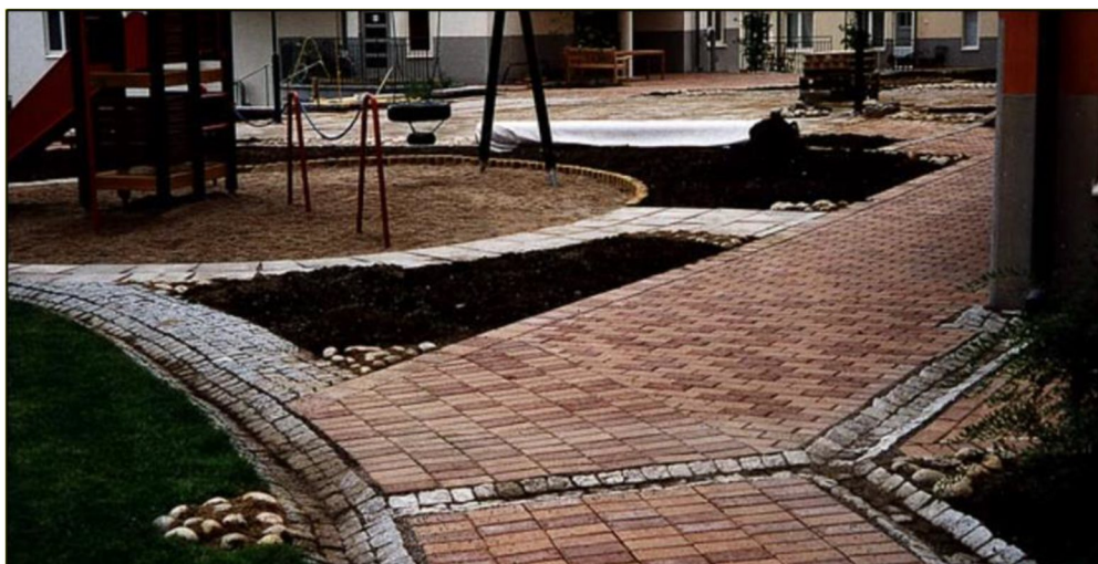
Figur 6-2. Exempel på avledning av takvatten via rännदार anlagda med gatsten (Källa: Stockholm Vatten AB, n.d.).
