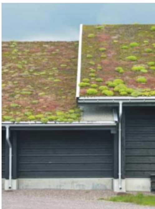
Exempelbilder på tunt grönt tak (till vänster) och tjockt grönt tak (till höger)
