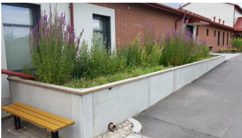
Figur 17. Exempel på upphöjda växtbäddar i lutande mark (Bildkälla: Dagvattenutredning Stockholmshem)
