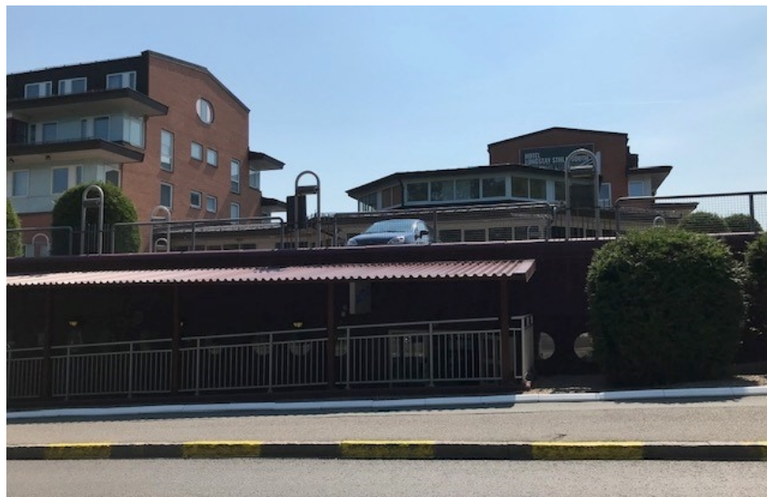
Vy över nordöstra delen av fastigheten där det idag finns bilparkering på körbart bjälklag. I underliggande byggnadsdel finns Actic gym och ett parkeringsgarage (Foto: SBK)
