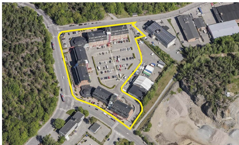
Flygvy över aktuell fastighet markerad med gul linje. Befintlig bebyggelse ligger i souterräng och går upp till som högst sex våningar i sydost och sju våningar i
