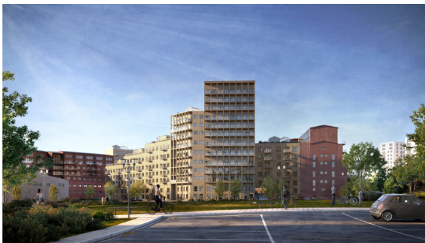
Orienteringskarta över L-huset i beige till vänster. Till höger visas en perspektivbild med vy över L-husets högsta byggnadsdel i tretton våningar som trappar ned i volym sidledes. Höger om trettonvåningshuset föreslås en portik för fri passage och garageinfart. (Bild: Tengbom)
