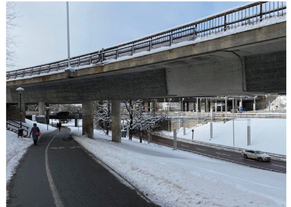
Gång- och cykelbana under Essingeledens ramper västerut.
