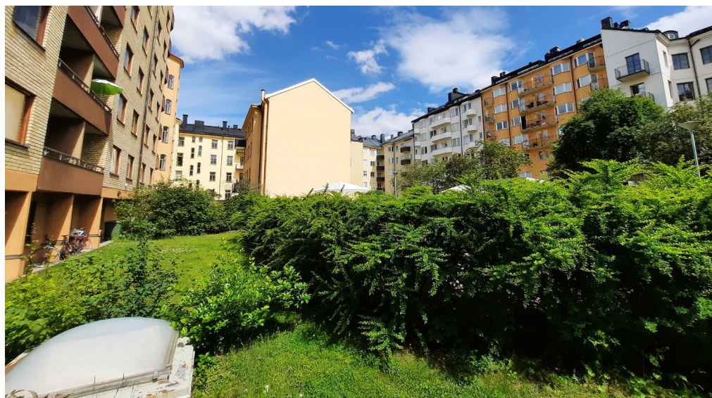
Byggnaden på Kumlet 23 till vänster i bild med de indragna partierna i bottenvåningen. Fönstret på bild i gräsmattan är en ventilationslucka ner till garaget som ligger under gården. Kvarvarande fristående gårdshus inom kvarteret syns i bildens mitt.
