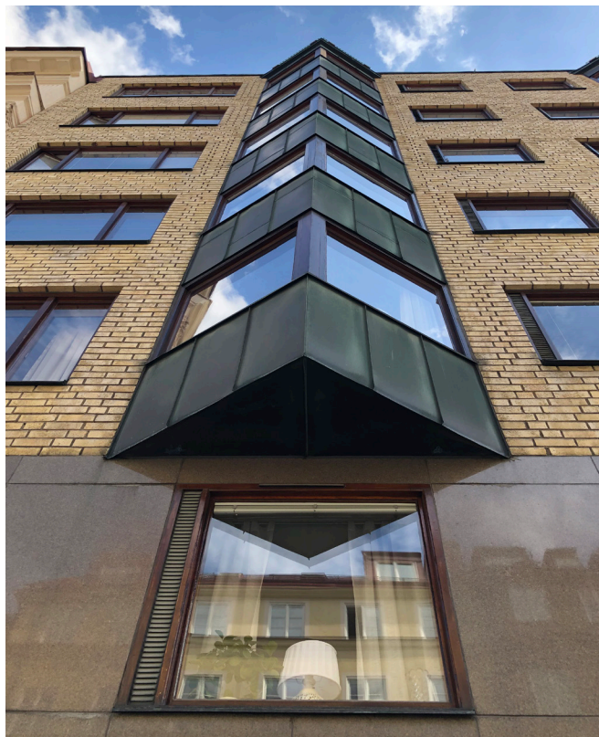
Karaktäristiska vinklade burspråk mot det gula teglet och den blankputsade höga sockeln. Fönstrens placering i fasadliv i sockeln är en typisk detalj på byggnadens smäckra materialmöten. Fönsterläget i liv med fasad framhäver också sockeln som mer sluten trots de många fönstren. Jämför med ovanförliggande fönsters placering som ligger indragna en sten i den tegelklädda fasaden.
