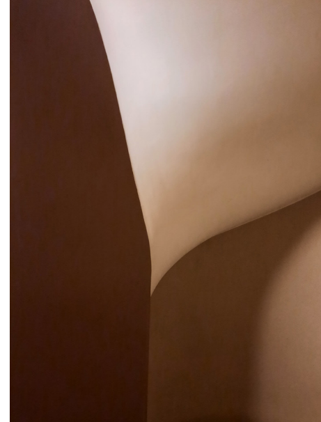
Undersidan av trapploppet har putsats in i en böljande form.
