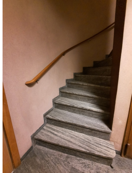
Trapploppet med granittrappor och handledare i trä.
