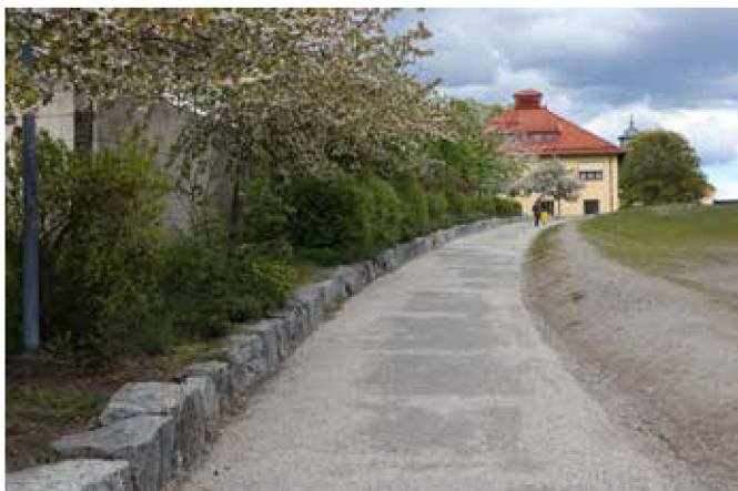
Nya campus anlades med vägar, gångvägar, planteringar och stödmurar.
