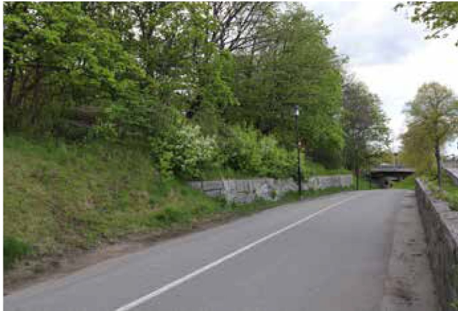
Cykelväg längs parkens norra sida mot Drottningholmsvägen. Stödmur av natursten mot parkens sluttning.
