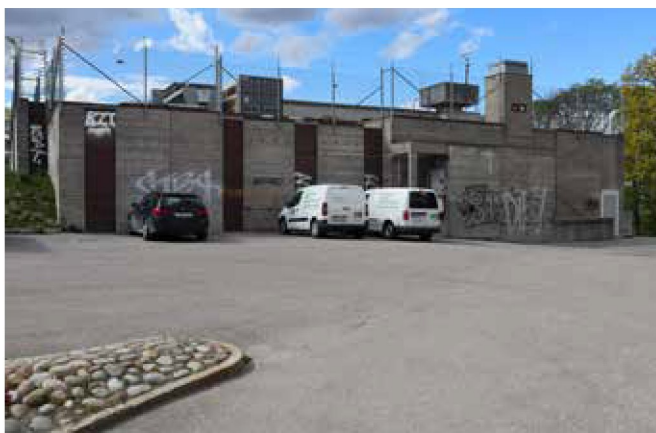
Telestation i betong uppförs år 1964.
