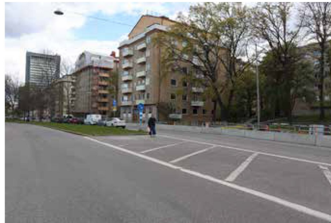
Bostadsbebyggelse i gult tegel uppförd under 1940-talet vid Rålambshovsvägen i Marieberg.
