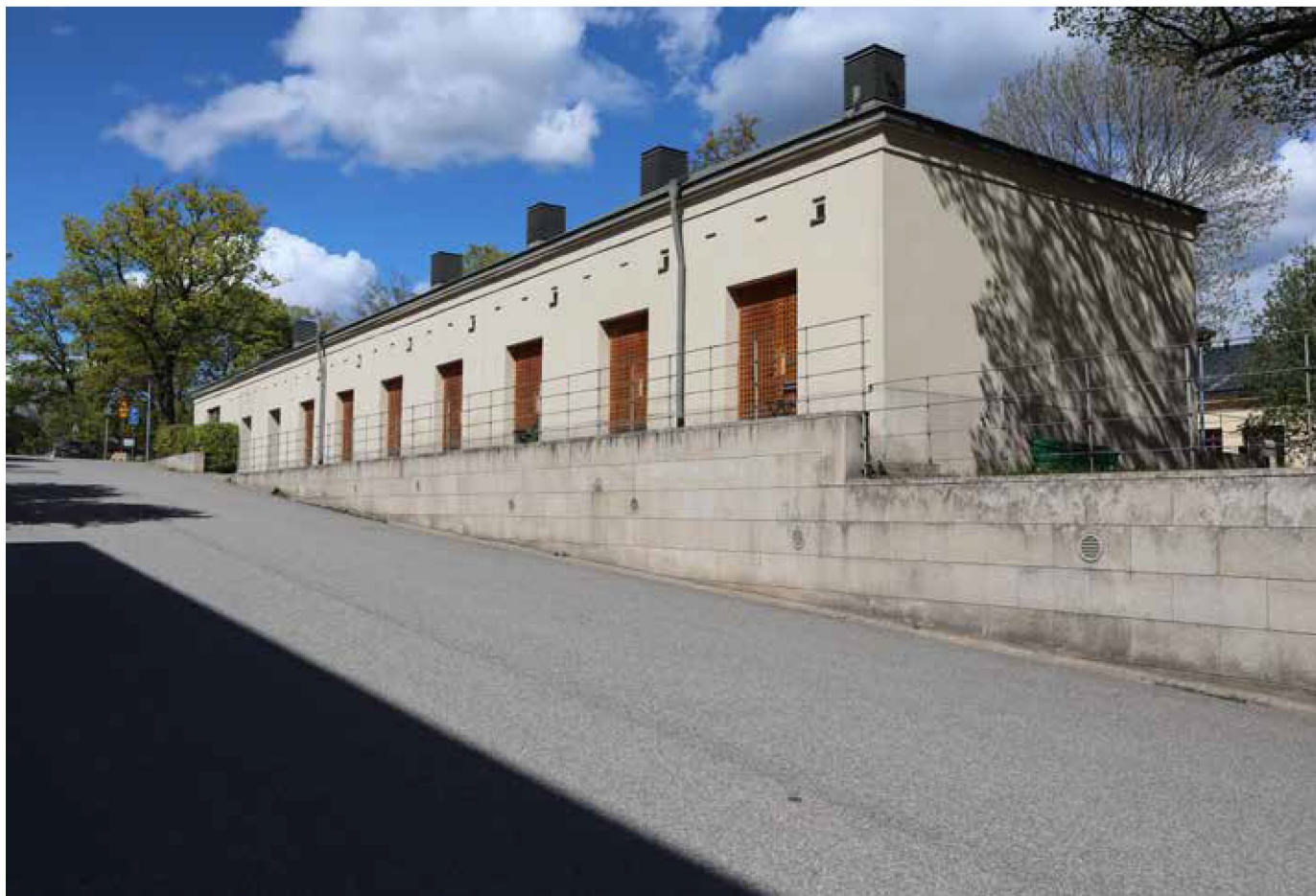
Konradsbergs flyglar byggdes till med studentbostäder. Byggnadernas utformning styrdes av detaljplan och uppfördes med slätputsade fasader och fönster av trä.
