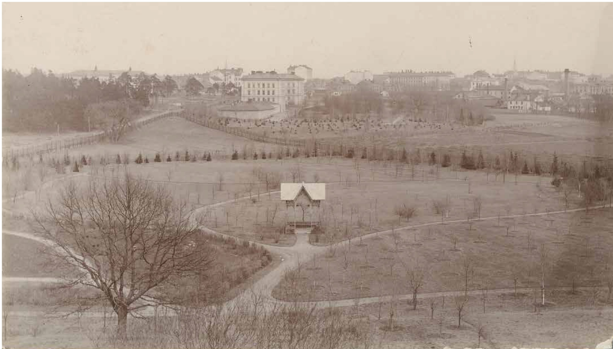
Fotografi från sjukhusbyggnadens trappa mot Stockholms sjukhem i öster. Fotot av den nyanlagda parken med gångvägar och nyplanterade träd är taget år 1881. Byggnaden i parkens mitt anges på ritningar vara ett "soltält". Digitalt stadsmuseum.
