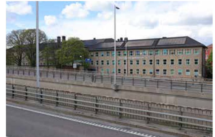
Thorildsplans gymnasium i gult tegel uppfört på 1940-talet efter Paul Hedqvist ritningar vid Drottningholmsvägen.
