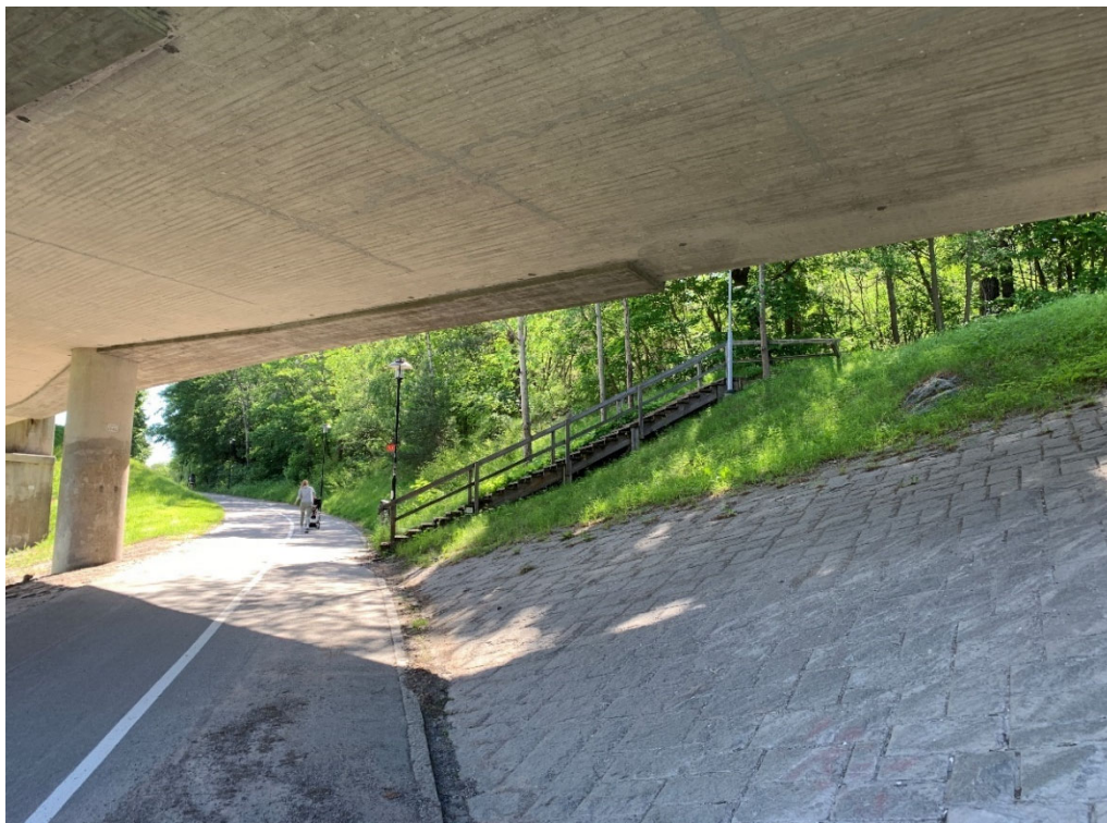
Foto 3. Vy från väster utmed gång- och cykelstråket under Mariebergssavfarten. Trappan, som är en del av den mycket gamla stigen från f.d. sjukhusområdet i nordväst, leder upp till platsen för telestationen och en skolbyggnad tillhörigt campusområdet.
