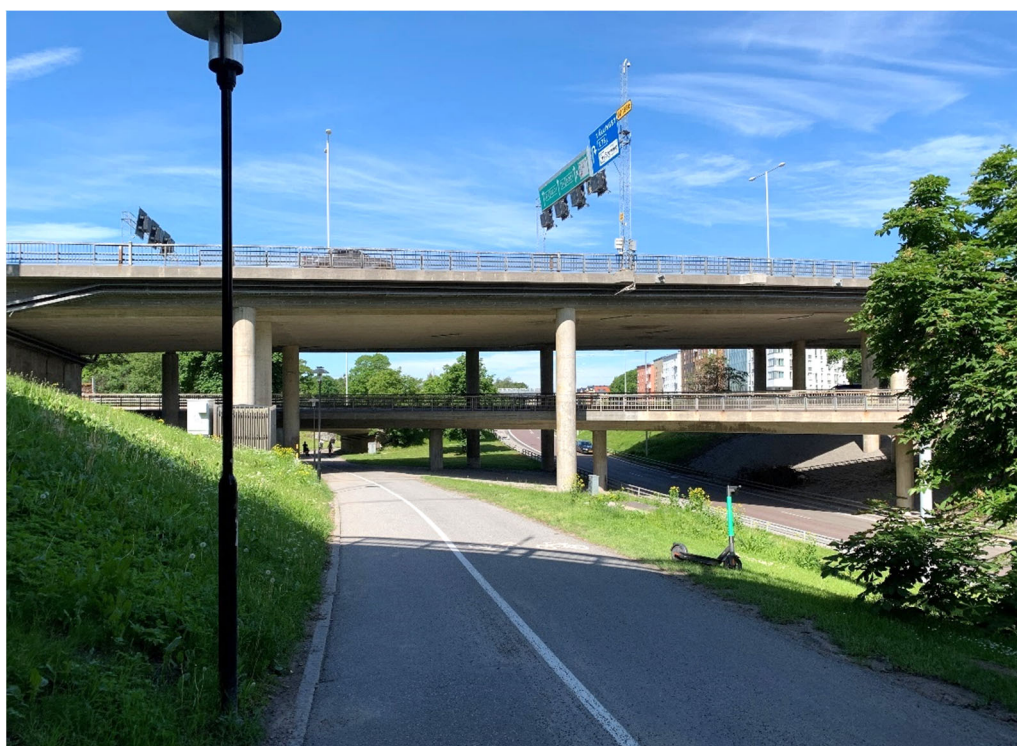
Foto 4. Gång- och cykelstråket från öster. Drottningholmsvägens södra del löper under Fredhällspåfarten och Essingeleden över den senare. I fonden skymtar Fredhällsparken.
