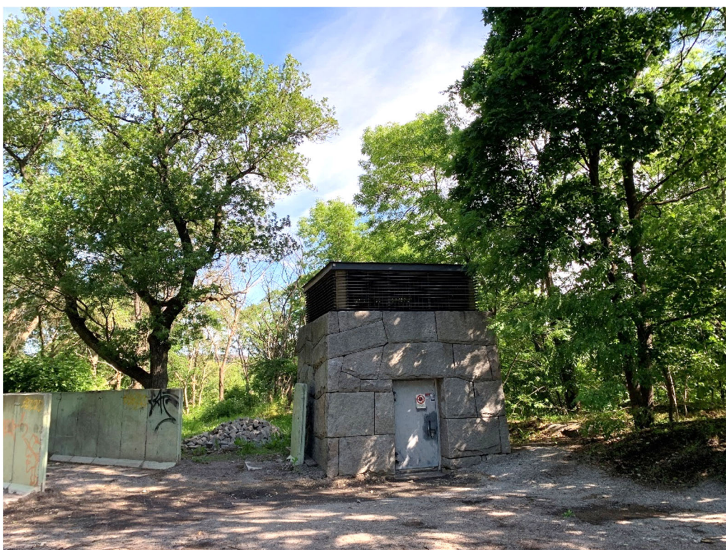
Foto 18. Ventilationstorn till telestationen sett från söder.
