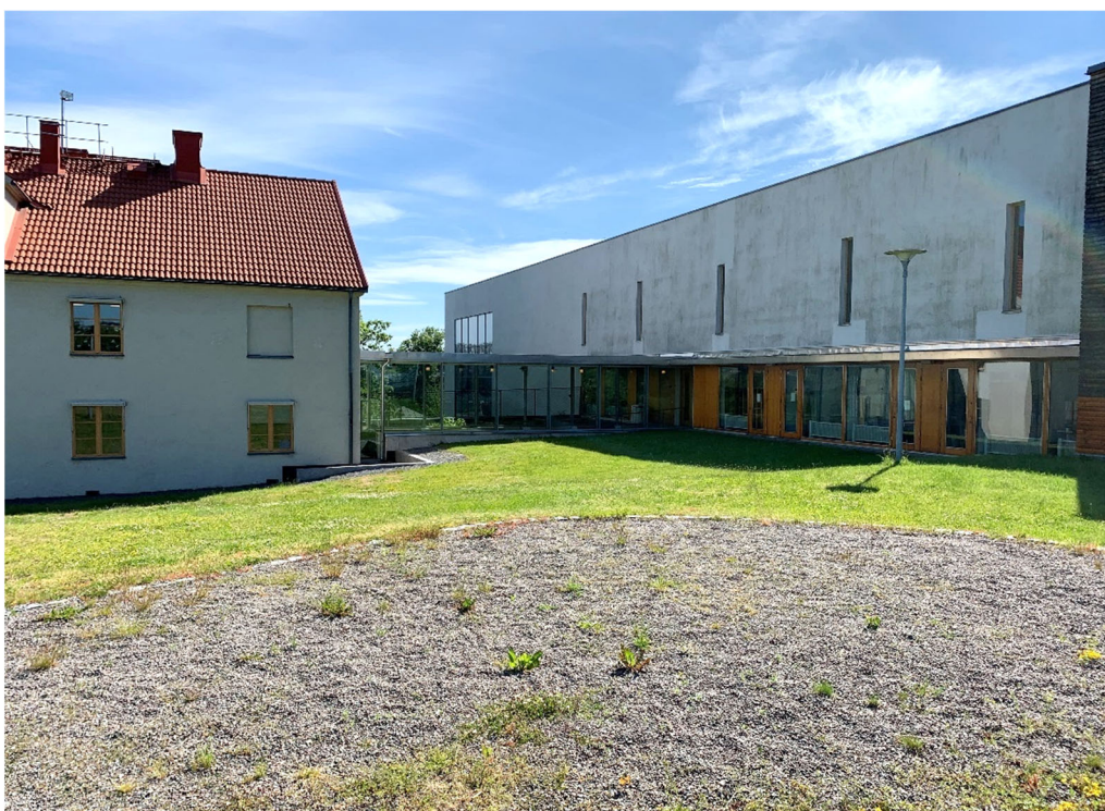
Foto 16. F.d. personalbostadshuset i vy från nordväst från samma plats som i foto 15 med Ellen Key-husets till höger. Husen nyttjas idag för Kungsholmens Västra gymnasium.
