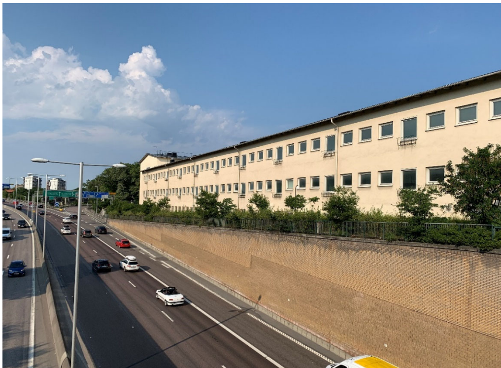
Foto 19. Vy från söder över Essingeledens passage med Mariebergsavfarten i fonden. Till höger syns f.d. Fredhälls folkskola uppförd under 1930-talet och naturmarkspartiet i sjukhusområdets nordvästra del. Träden döljer befintlig telestation.
