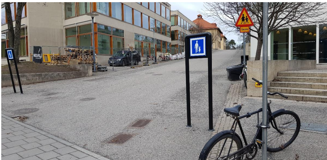
Figur 2 Konradsbergsgatan som leder från Rålambsvägen till planområdet. Konradsbergsgatan har en brant lutning och saknar trots gågataregleringen hastighetsdämpande möblering.
