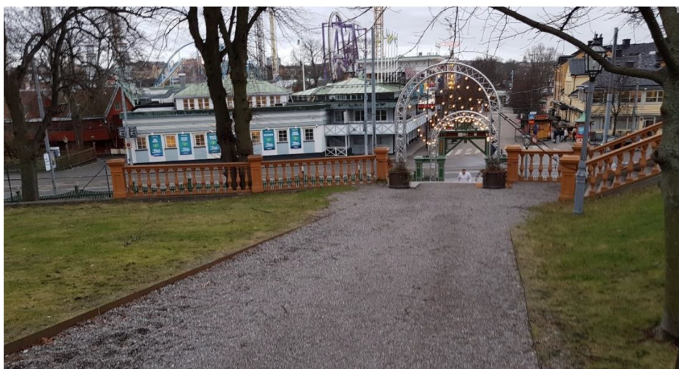
Figur 9. Foto från platsbesök 2020-02-10 som visar erosionsskador av grusgång där stora mängder grus transporteras på grund av avrinning längs med gångstråket ned mot Djurgårdsvägen.
