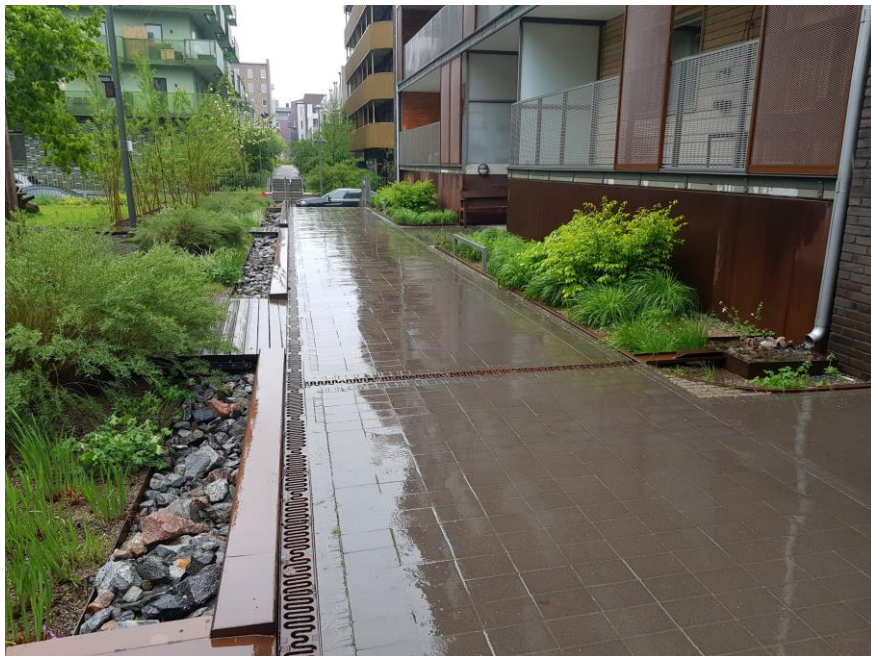
Figur 15. Ex. på utkastare från stuprör med ränndalar till växtbädd.
