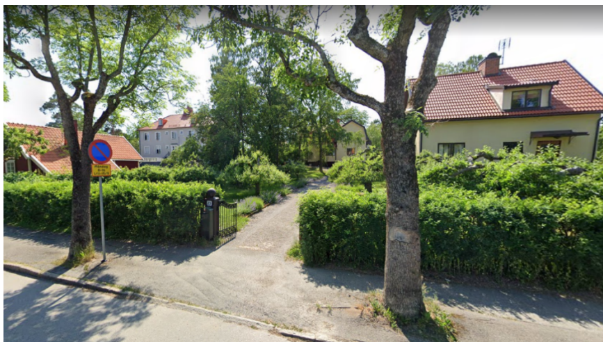
Fastigheten Siklöjan 8, med två enbostadshus med gula fasader, sedd från Vivelevägen i sydlig riktning. Bild tagen från Google street view.
