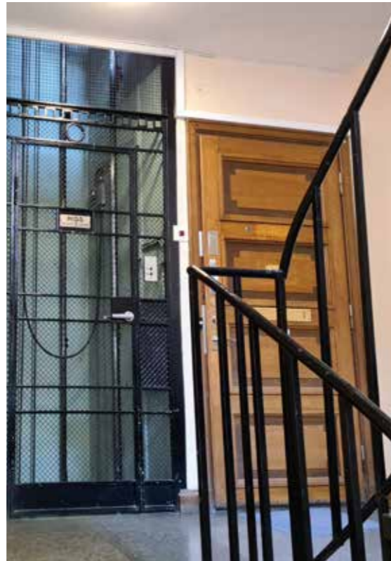
Trapphus mot Kammakargatan med i hög grad ursprunglig gestaltning.
