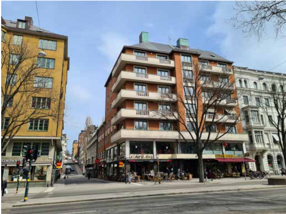
Vy in mot Kammakargatan med Moraset 23 till höger och den samtidigt uppförda grannfastigheten till vänster som är ritad av samma arkitektfirma, men formgiven i mer renodlad funktionalism.
