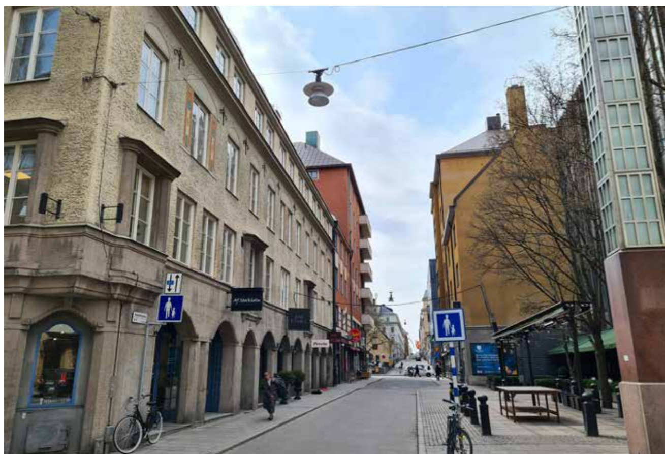
Kammakargatan mot Sveavägen med det rödfärgade Moraset 23 till vänster som angränsar till ett jämnhögt ljust putsat hus i fyra våningar från 1915. På andra sidan Kammakargatan ligger det gulputsade huset som också uppfördes i början av 1930-talet med en högdel mot Sveavägen och en lågdell mot Kammakargatan. Närmast i bild öppnar sig gaturummet till höger mot ett storskaligt, delvis indraget komplex från 1975.
