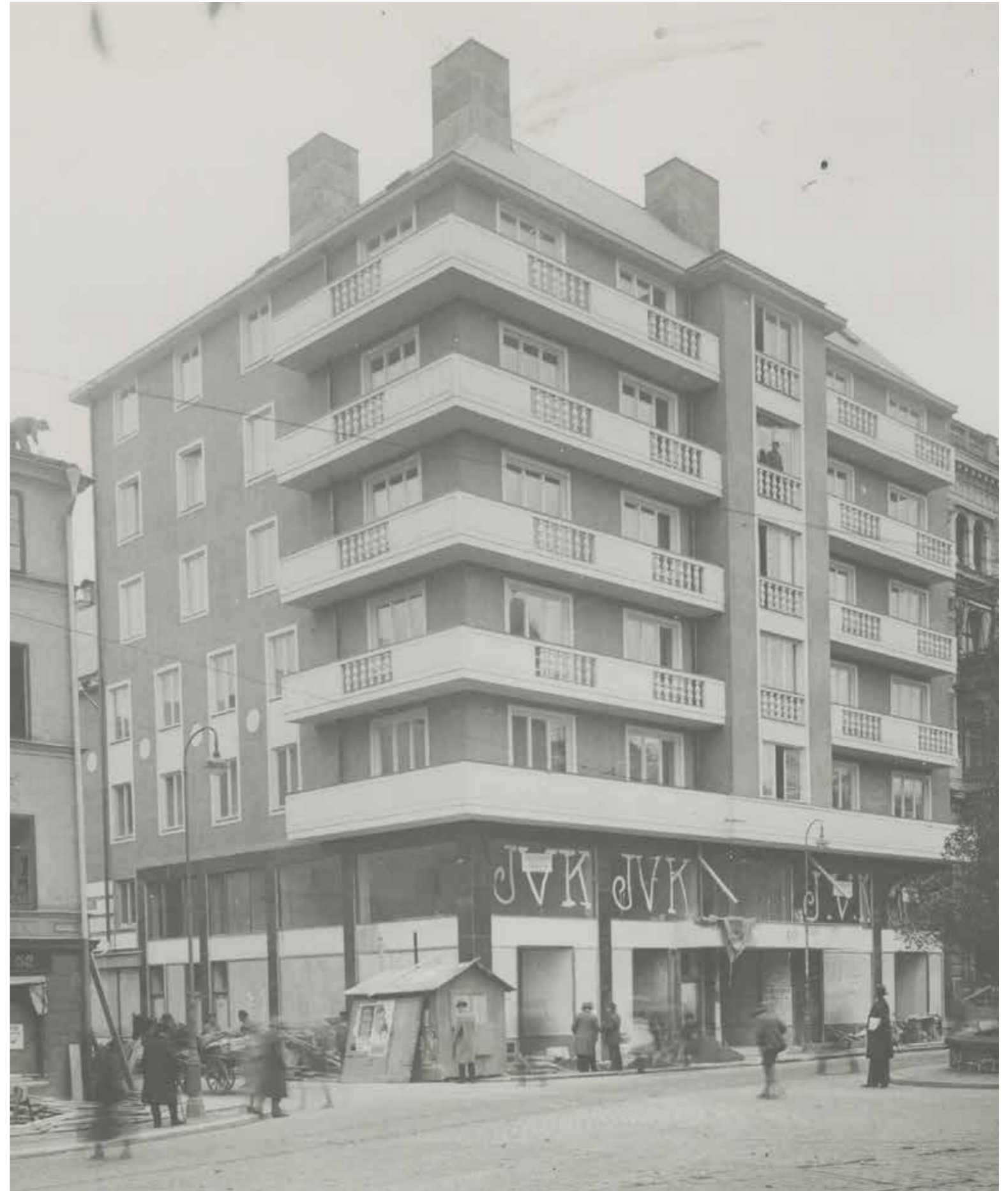
Hörnhuset på Moraset 23 i byggnationens slutskede. Byggnaden är i hög grad oförändrad sedan uppförandet. Fönstren tycks dock ha varit ljusa till skillnad från dagens blå. De nedre våningsplanens smäckert utförda butiksfönster är till stor del intakta. På bilden framgår även att byggandet av grannhuset på hörnet mitt emot ännu inte har påbörjats trots att det står i handlingar att det ska vara färdigställt samma år som Moraset dvs 1931.
