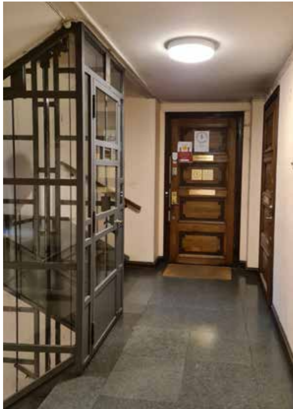
Trapphus mot Sveavägen med i hög grad ursprunglig gestaltning. Trappor i kalksten, lägenhetsdörrar i ek och hissbur.
