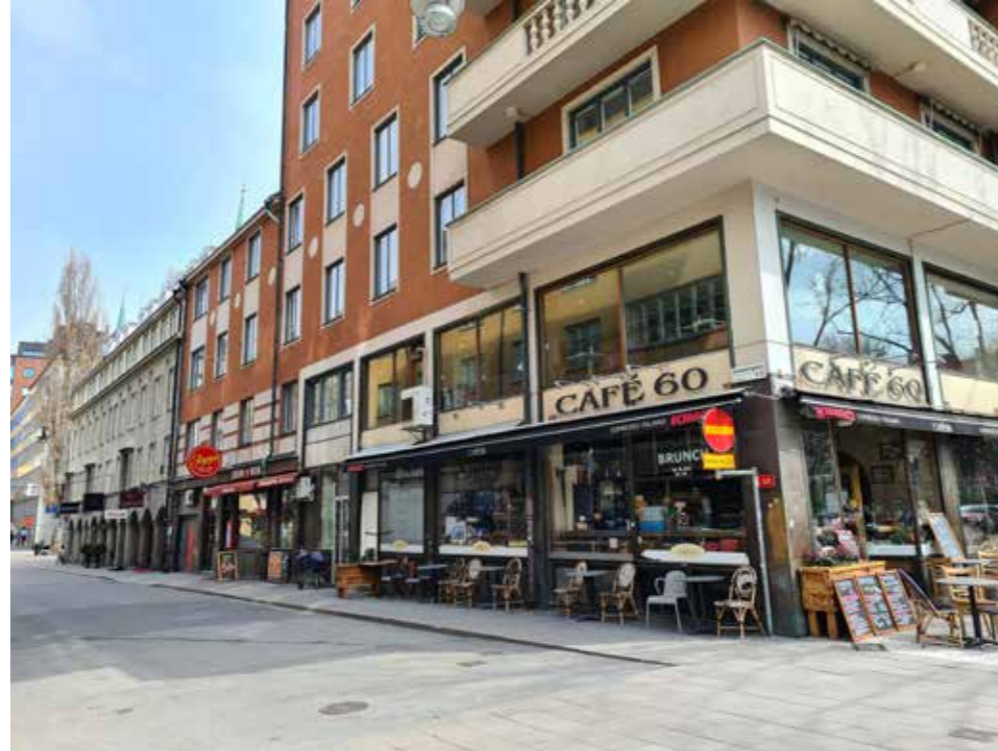
Moraset 23 är formgiven med uppglasade butiker och lokaler i de två nedre våningsplanen mot Sveavägen. I den lägre delen utmed Kammakargatan endast i bottenvåningen.
