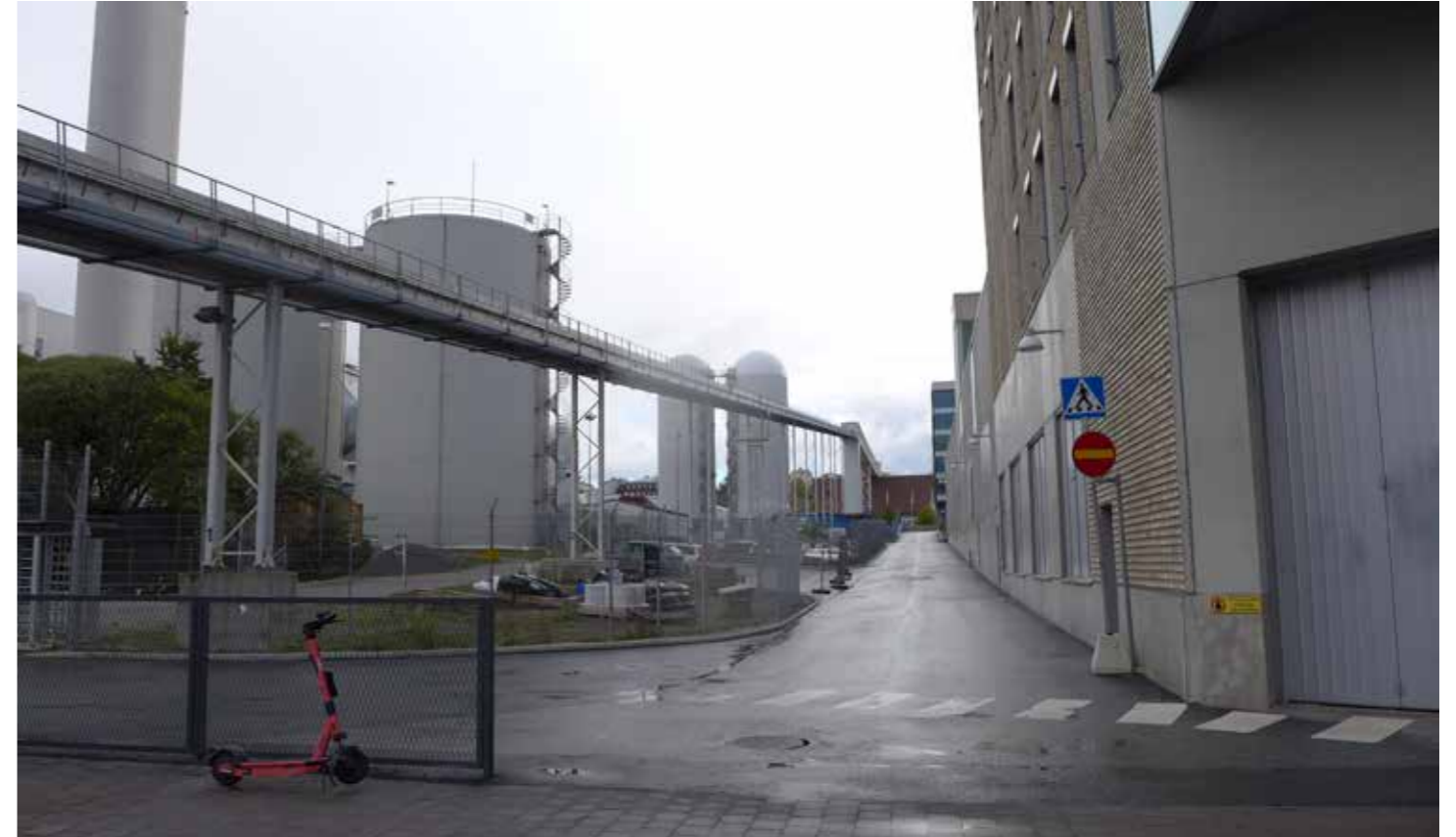
I bild syns Hammarbyverket med dess 275 m. långa bandtransportör från kajområde till betongfabrik/ballastterminal.
