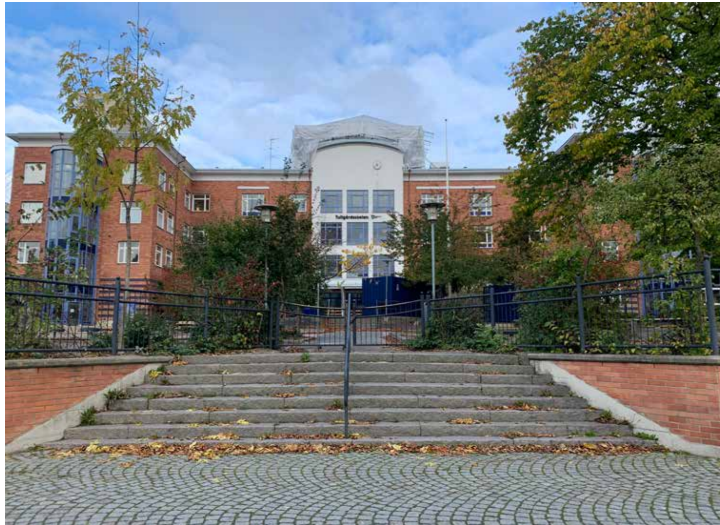
Tullgårdsskolan sedd från kajen. Växtligheten på skolgården är av stor betydelse för stadsbilden längs kajen.
