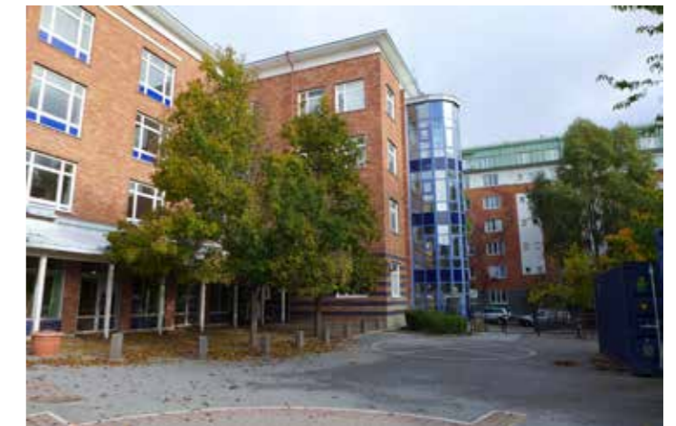
Utvändiga uppglasade trapphus med plåtklätt ljusblått ramverk och mörkblå utfackningspartier.
