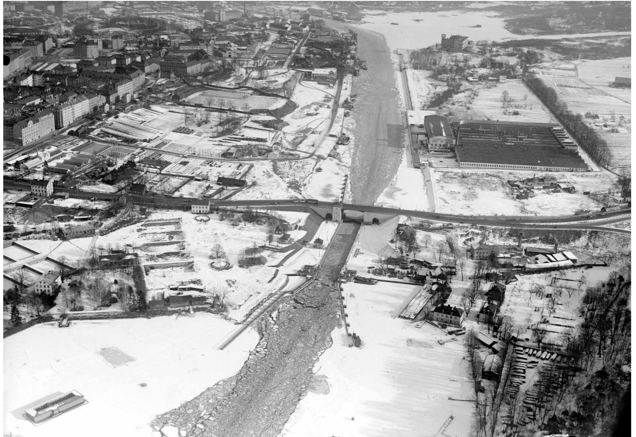
Flygfoto över norra och södra Hammarbyhamnen, ca. 1929-31. Tomten där Tullgårdsskolan ligger idag är bebyggd och brukas sannolikt som mindre industri. Nyplanterade träd längs Östgötagatan och träd inom det som så småningom ska bli Tullgårdsparken. Källa: SSM.
