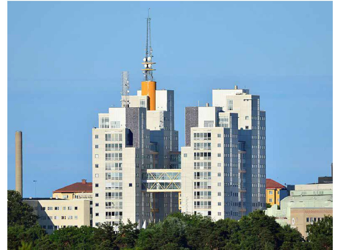
Globen city, uppfört 1989 efter ritningar av Berg Arkitektkontor AB, som även ritade Globen. Globenområdet är ett av de tydligaste postmodernistiska exemplen i Stockholm. Källa: Wikipedia.
