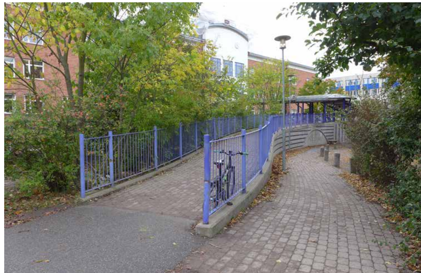
Gångbron avslutas i en betongramp mot parken.
