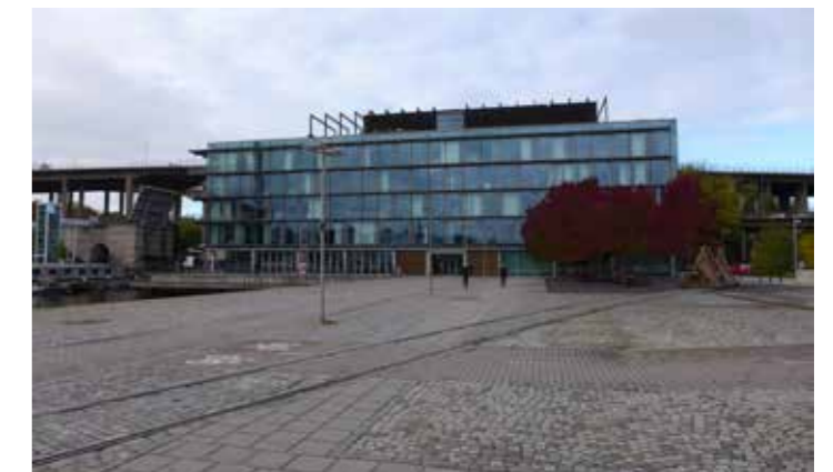
Östgötagatan mynnar ut i ett stort öppet torg med bänkar och trädplanteringar. I bild syns Whites kontorshus från 2003.
