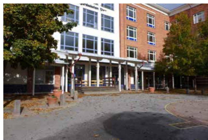
Huvudentré mot skolgården med skärmtak uppbyggt av träpelare. Notera tidstypiska detaljer så som glaserade tegelband i bottenvåningen och spröjsade plåtinklädda kulörta fönster.
