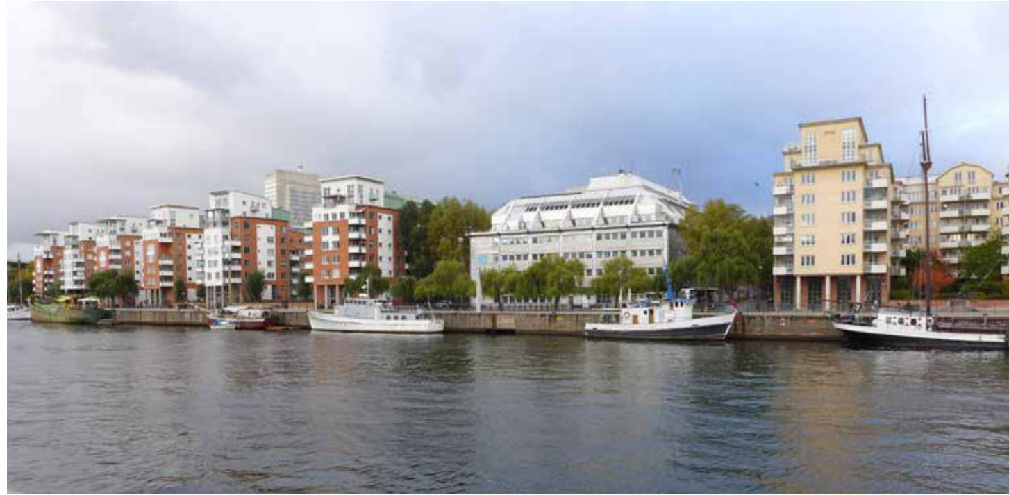
Norra Hammarbyhamnens bostadsbebyggelse från 1990-talets början. I bild syns även byggnaden i kv. Hönsfodret som uppfördes år 1983 för Folksam.
