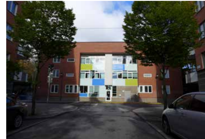
Förskolan Skeppets arkitektur har anpassats till den anslutande postmodernistiska bebyggelsen.
