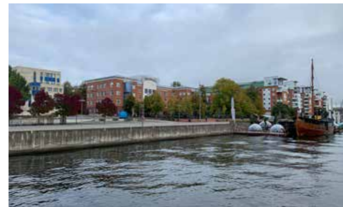
Tullgårdsskolans planform- och fasadgestaltning ansluter till bostadsbebyggelsen i kv. Tullstugan 3. Byggnaden förhåller sig även till skalan för Folskams kontorshus i öst.
