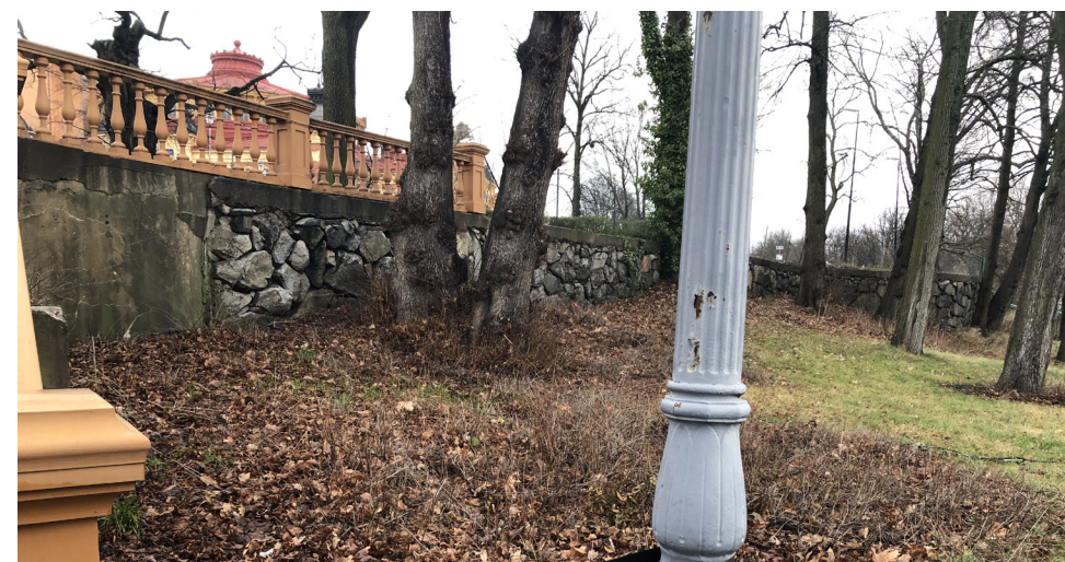
Terrassmur från 1800-tal med nyare pågjutningar av betong. Muren ligger i anslutning till den nuvarande parkeringsplatsen. Fram till flytten 1963-65 låg Gubbhyllan på platsen och muren är uppförd i anslutning till denna.
