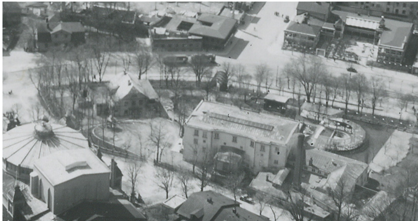
Bilden från år 1931 visar en musikpaviljong i mittaxeln från huvudbyggnaden. I norr syns den svängda pergolan. Söder om huvudbyggnaden syns en cirkulär struktur som rotundan senare kommer att förstärka. Foto Oscar Bladh. Källa: Digitala stadsmuseet.
