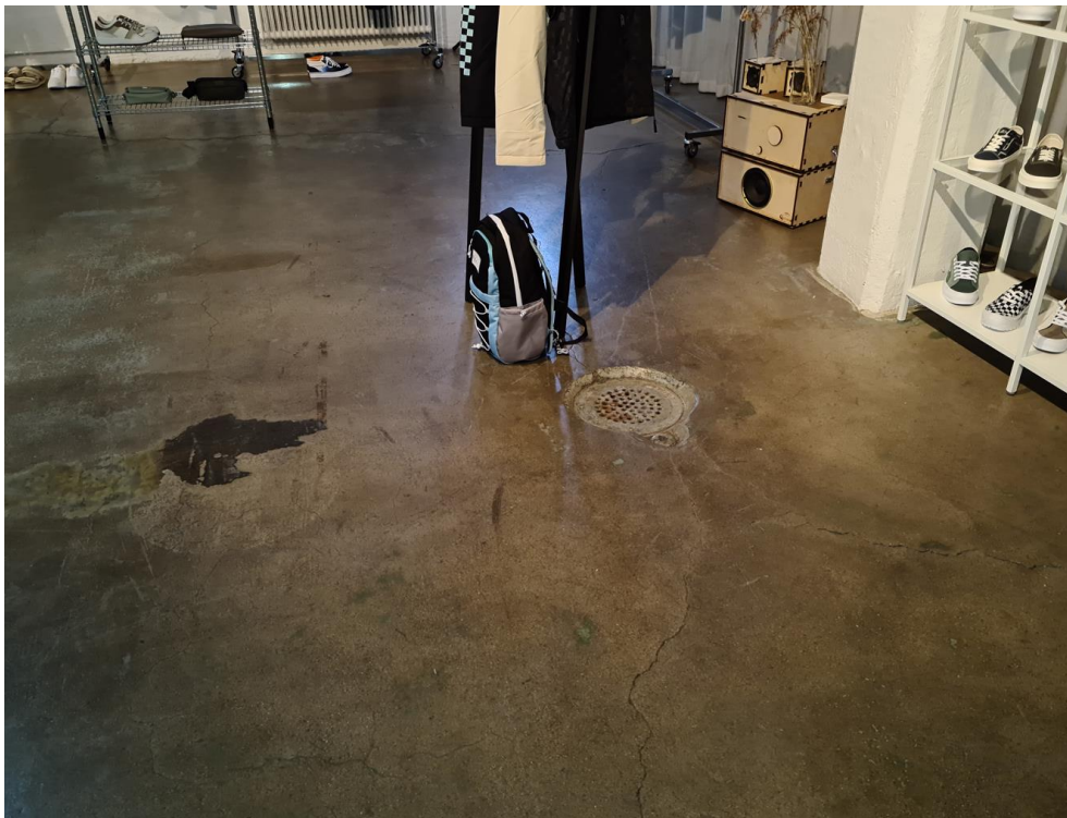
Figur 3. Foto på betongplattan samt en avrinningsbrunn.
