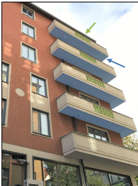
Figur 3. Förslag på åtgärder vid balkonger (gäller även Sveavägen): glasskiva vid öppningar i balkongräcke (grön) samt ljudabsorbenter i balkongtak (blå).
