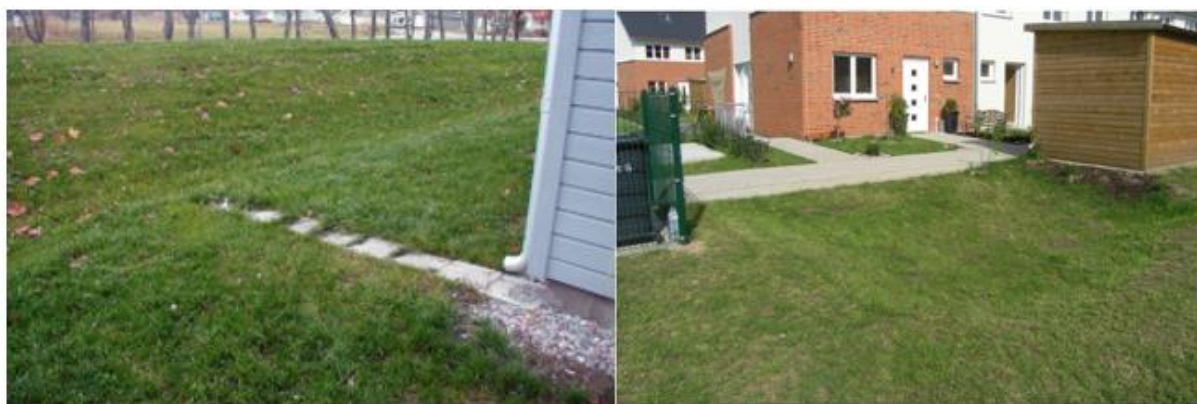
Figur 5. Exempelbilder infiltration i gräsytor. Bildkälla: Stockholm Vatten och Avfall.
