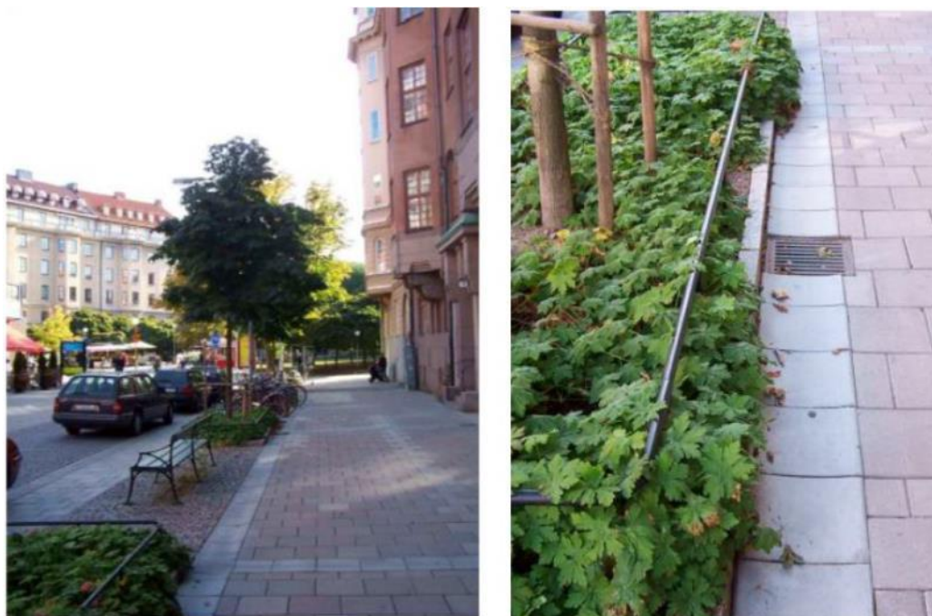
Figur 3. Träd planerade i skelettjord på Erik DahlbergsAllén med anslutande rännstensbrunn (Bildkälla: Stockholm Vatten och Avfall)
