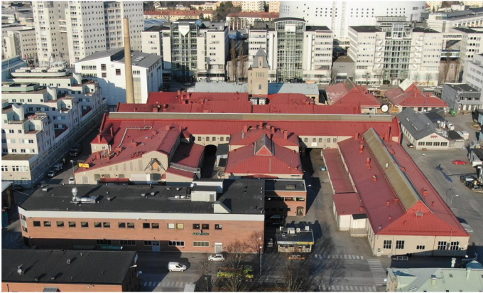
2021. Anläggningen från väster.
