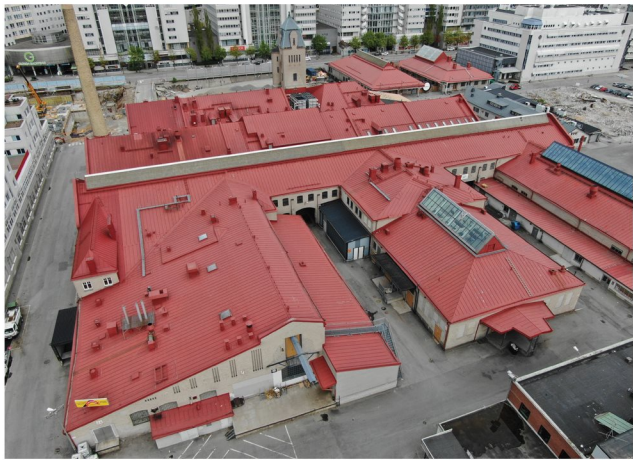
2021. Anläggningen från väster.
