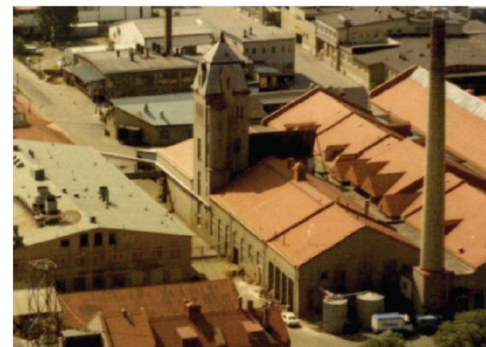
1976. Notera de igensatta fönstren på hus 13. Bildkälla Arkiv Digital.
