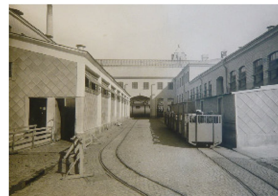
Ursprunglig utformning gränden mellan hus 24 och 25.
