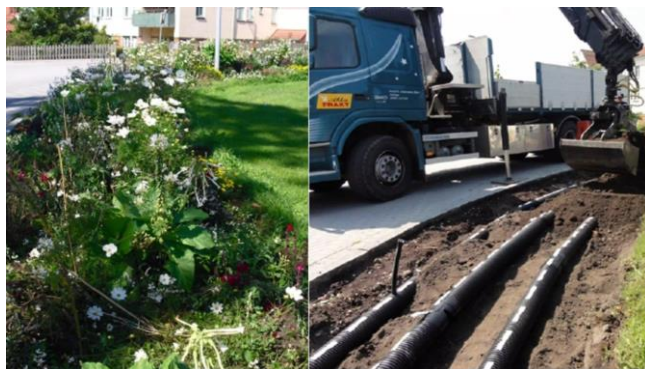
Figur 12. Exempel på dräneringssystem. Savaq-system
