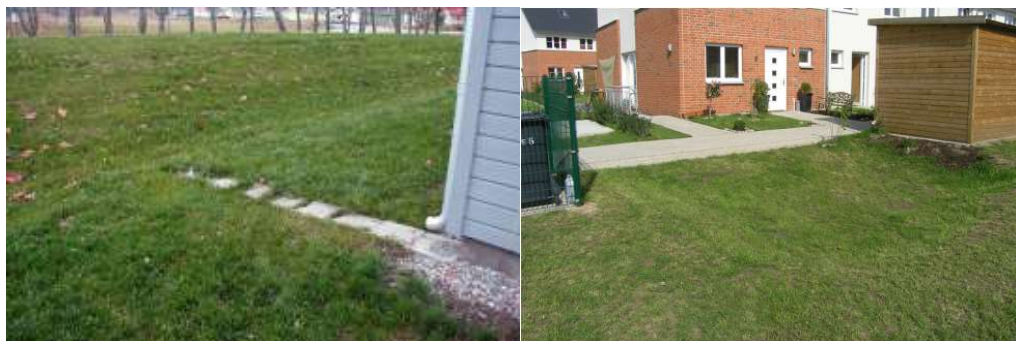
Figur 25. Exempelbilder infiltration i gräsytor. Bildkälla: Stockholm Vatten och Avfall.
