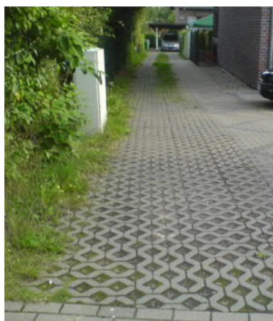
Figur 15. Två exempel på genomsläpplig beläggning - rasterytor med gräs (WRS).
