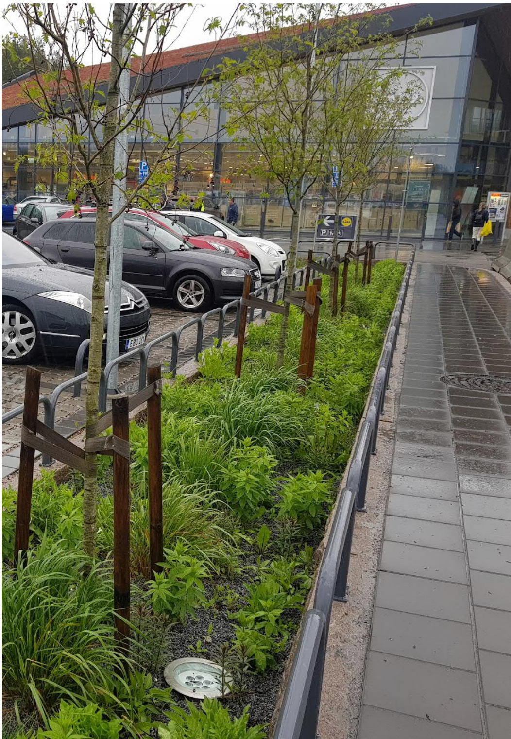
Lidl, Sigtuna Stadsängar, regnbäddar i kolmakadam, (Sweco mfl. 2020, foto Sweco)
