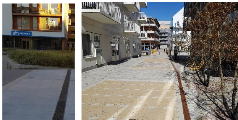
Figur 21. Linjeavvattnning med utlopp i plantering, Norrköping och Linköping.
