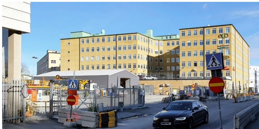
Befintlig kontorsbyggnad på fastigheten Korhoppet 1. (Bild: Stockholms stad)
