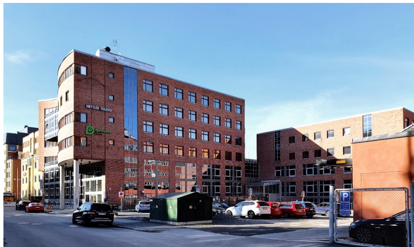
Befintlig kontorsbyggnad på fastigheten Trikåfabriken 4. (Bild: Stockholms stad)
