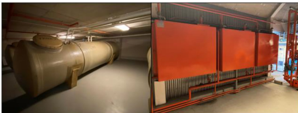
Figur 3. Bild till vänster visar en av dieseltankarna. Bild till höger visar tre av dagtankarna.
