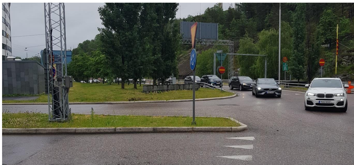
Figur 11. Köbildning på Södra Länkens avfartsramp från Nacka, eftermiddag.
