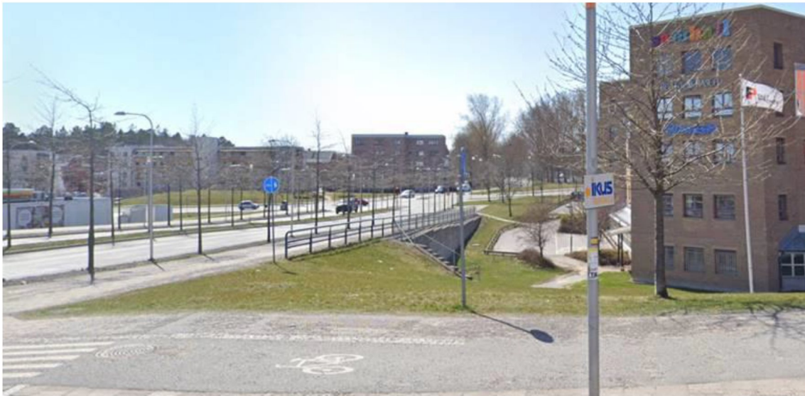
Figur 30: Befintlig situation vid Norgegatan
