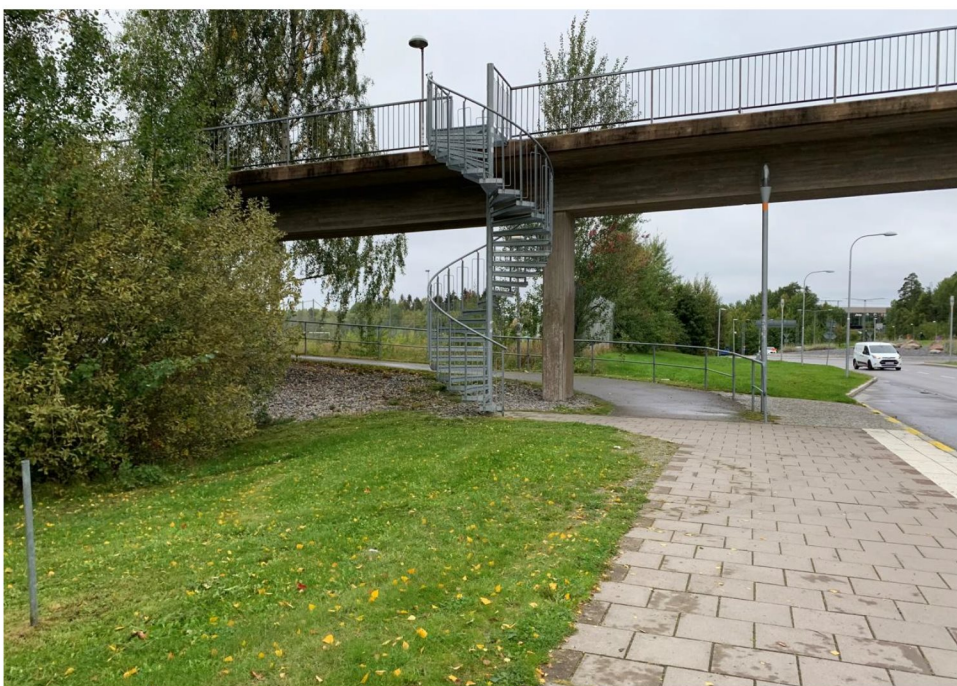
Figur 5: Trappa och gångkoppling från Telemarksbron, till hållplats Kistahöjden
