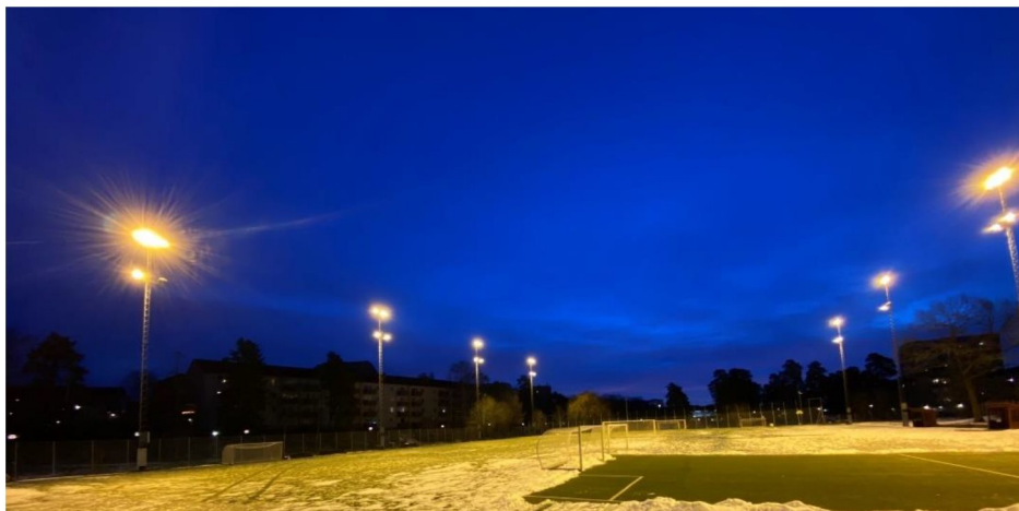
Bild 3 – Bild på belysningsmasternas placering utmed långsidorna, totalt åtta stycken.
